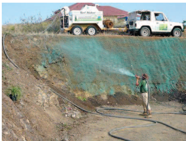
figure 16 : ensemencement d'un talus par hydroseeding, source : hydroseed.nc
