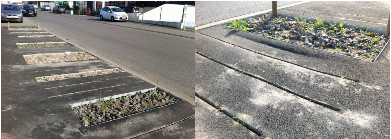
figure 21 : aménagement de l'avenue F. Mitterrand, avant la pousse des végétaux, Olonne sur mer, source : Phytolab (10/2012)
