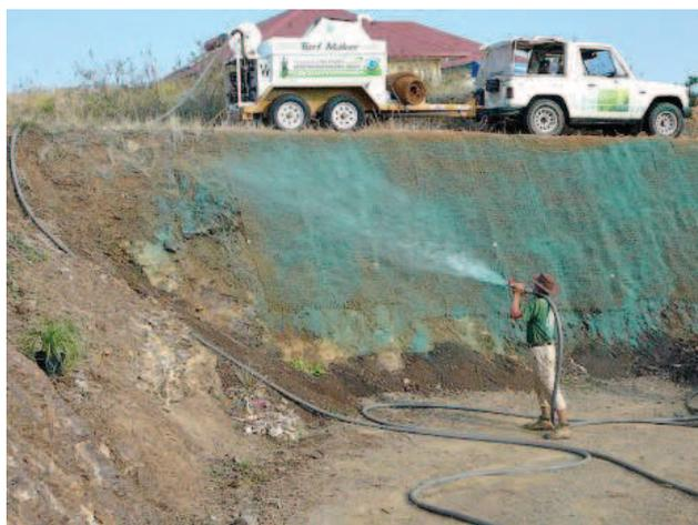
figure 16 : ensemencement d'un talus par hydroseeding, source : hydroseed.nc
