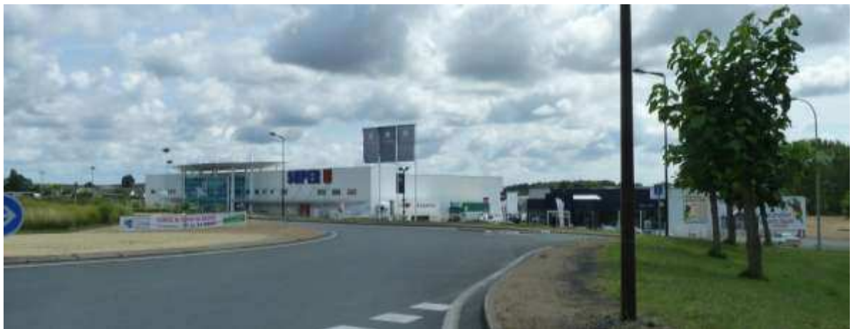
Figure 2 : Une entrée de bourg marquée par une extension commerciale qui banalise le bourg (aux alentours de Baugé, le 7/08/2014, Sandrine Lambert)
