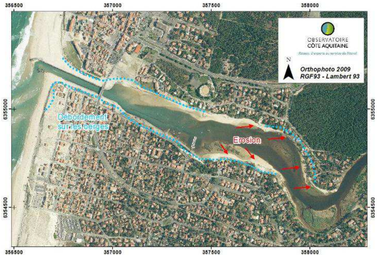
Figure 28 : Débordements sur les berges et forte érosion en amont du courant (70)
