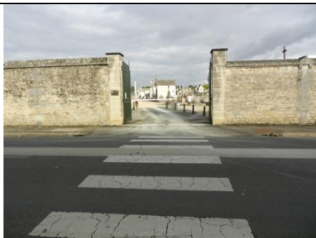
Entrée principale côté route de Saint Jean d'Angély (L. Morange, 2013)
