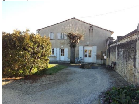
Entrée secondaire côté route de Saint Jean d'Angély et l'accueil (L. Morange, 2013)
