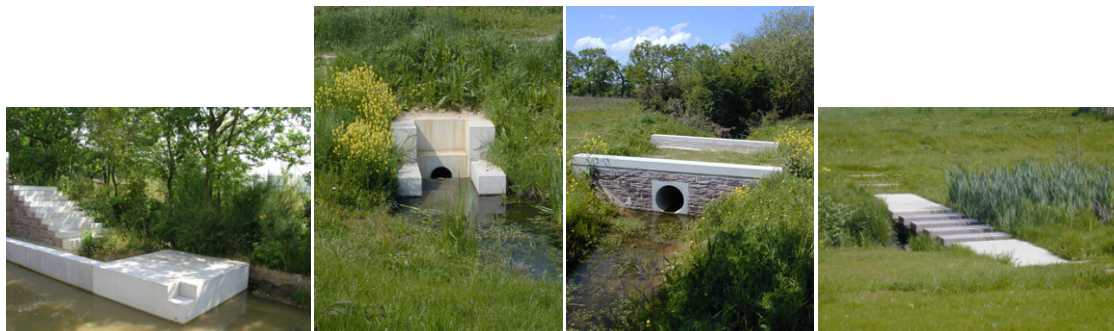
Figure 18 : Petits ouvrages de seuils, gués, déversoirs et avaloirs © Bruel-Delmar
