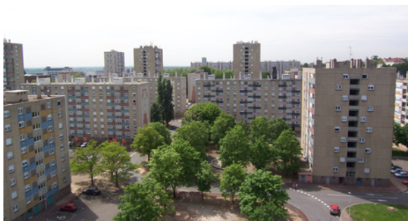
Figure 22 : Vue du quartier Marbé à Mâcon, avant travaux. In Situ, 2005.
