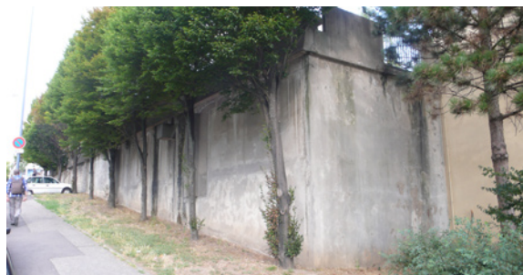
Figure 10 : La dalle basse vue de la rue Bizet. In Situ, 2011.
