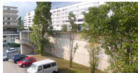
Figure 13 : La fosse Wagner et son escalier. In Situ, 2011.
