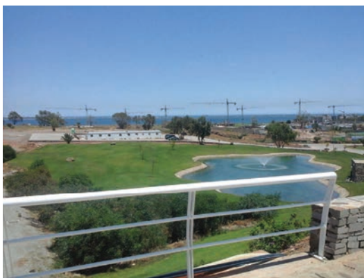
Figure 8 : Travaux en cours de l'Académie de Golf, péninsule d'Atalayoun. Juin 2014, V. Rivière.
