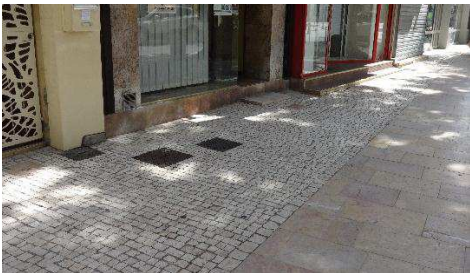
Fig.23: Gestion du nivellement à l'aide d'une bande pavée le long du domaine privé afin de rattraper les différences altimétriques - Châteaurenard (13) - 2014 - Charrier O.
