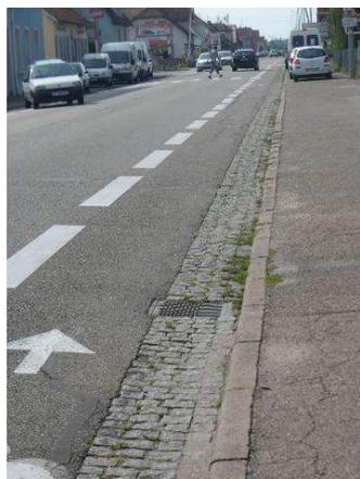
Haguenau présente la particularité d'avoir beaucoup de caniveaux en pavés. (fig. 19). L'alignement de pavés se constitue de rangées de petits pavés (jusqu'à quatre rangées) où les herbes spontanées s'installent facilement, surtout si les joints sont abîmés. Il faudrait envisager la mise en place d'un programme de réfection des joints.
