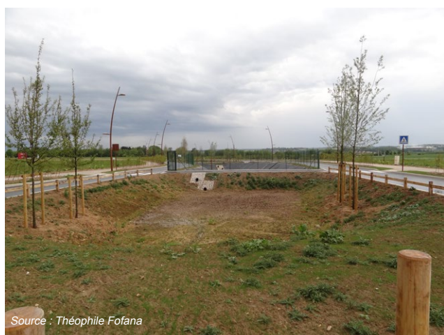
Figure 22 : Bassins de rétention et de stockage des eaux pluviales dans la Zone d'Activités des Moulins
