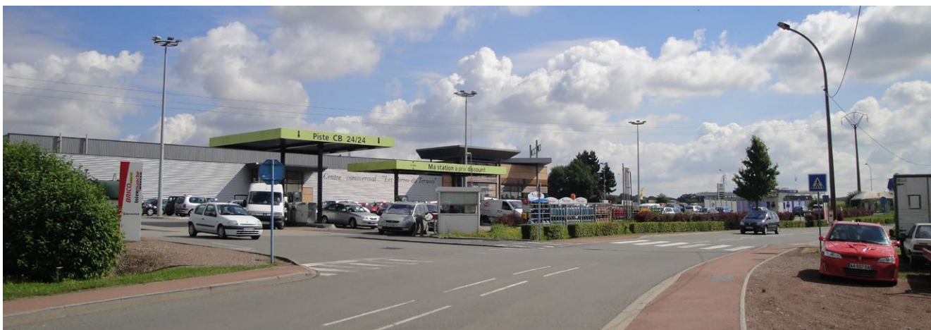
Figure 15 : Zone commerciale Porte Nord de Saint-Pol-sur-Ternoise, vue à partir de la D87, AULAB
