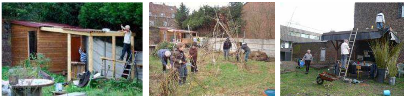
Figure 26 : Photos de différents chantiers participatif (abris de jardins, structures en saules) menés par l'association (source : les AJOncs)
