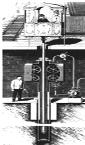
Figure 4 : Machine de levage à eau et à vapeur, XIXème siècle
