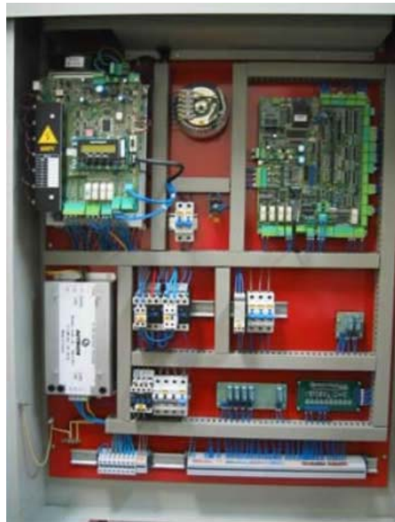
Figure 28 : Tableau AUTINOR MB32 équipé d'un variateur de vitesse VEC mod2
