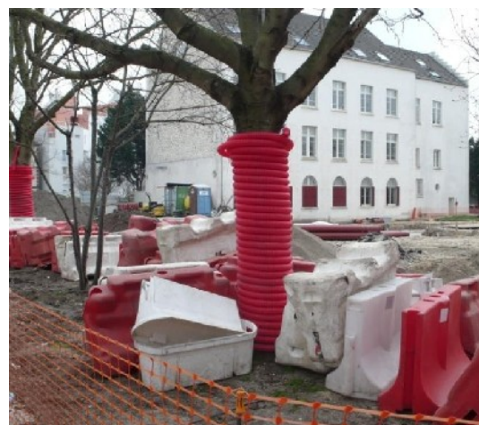
Figure 15 : exemple de protection demandée dans les CCTP (Hollande) (Lopez M. 2014)
