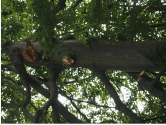
Zone d'insertion des charpentières après la chute
