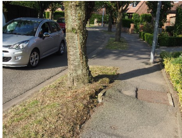
Figure 10 : Blessures racinaires lors du creusement d'une tranchée et soulèvement d'enrobés causé par les racines de PRUNUS Serrulata sur Roncq (Lopez M. 2014)
