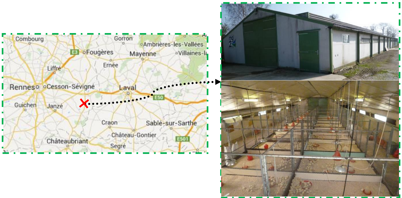
Figure 7 : Localisation et vues extérieure et intérieure de la station expérimentale
