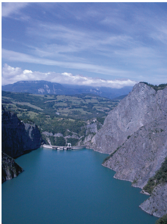
Barrage hydroélectrique de Monteynard Source : Rault, S. 2007
