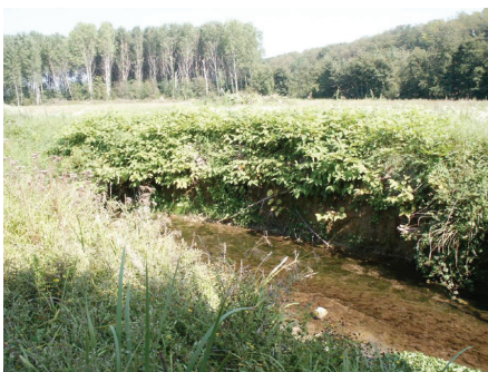
Erosion des berges
