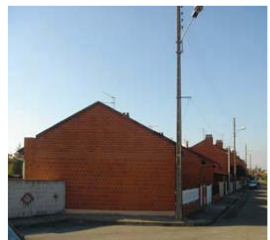
Figure 23: Façades des logements, JP. Cordier, photographie
