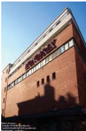
Figure 19: Monoprix, réalisé entre 1951 et 1967, à Toulouse par Paul de Noyers.
