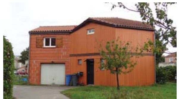
Figure 40: Maison Garance avec brique de cloison de hauteur d'étage, photographie personnelle
