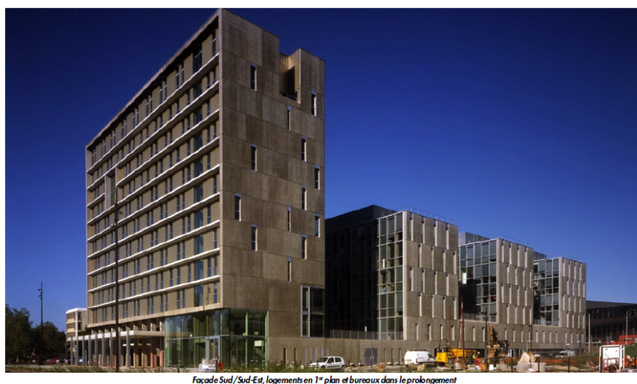
Figure 30 : Photo du quartier du Tripode à Nantes – Ilôts B
