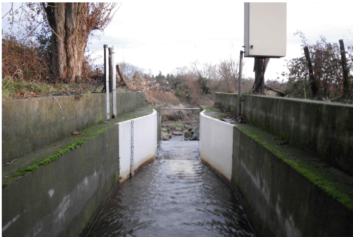
FIGURE 34 – Photo de la section de contrôle de la station hydrométrique de la Léchère
