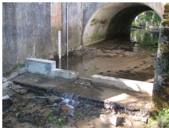
(b) Contrôles hydrauliques après les travaux : de janvier 2014 à aujourd'hui.
