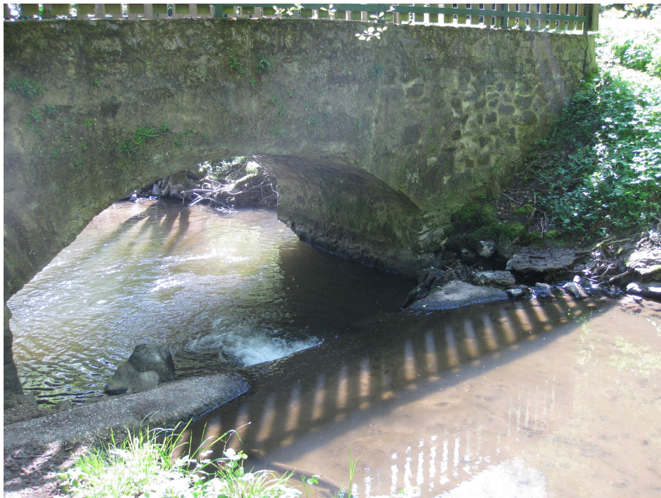
FIGURE 18 – Photo de la section de contrôle actuelle de la station hydrométrique de Craponne.
