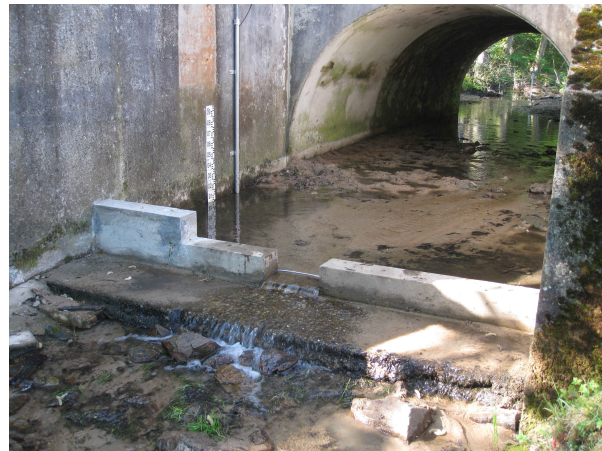
(b) Contrôles hydrauliques après les travaux : de janvier 2014 à aujourd'hui.
