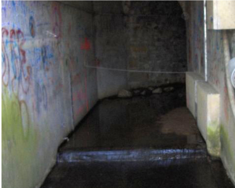
FIGURE 31 – Photo de la section de contrôle de la station hydrométrique de Pont de la Barge
