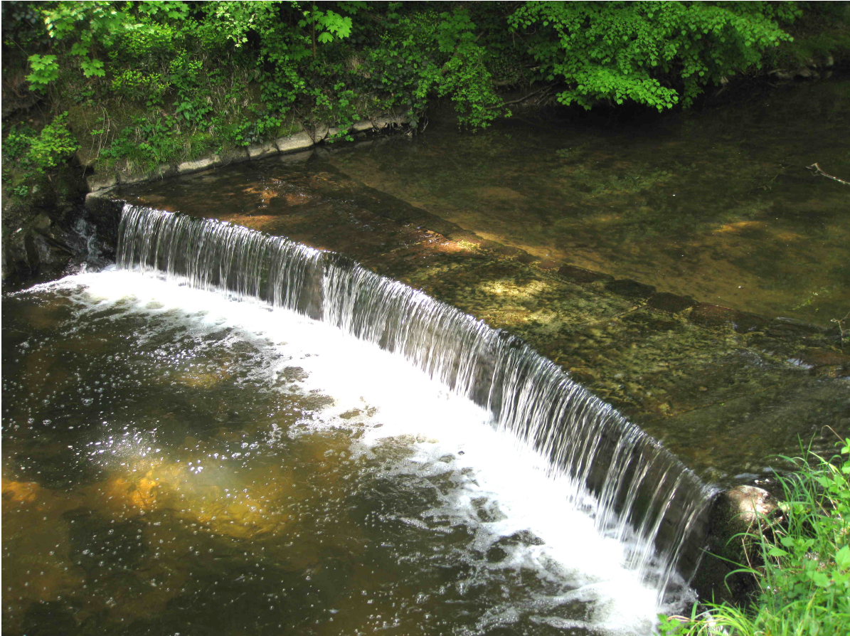
FIGURE 27 – Photo de la section de contrôle de la station hydrométrique de Taffignon
