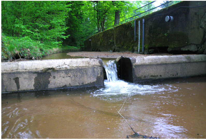
FIGURE 15 – Photo de la section de contrôle de Charbonnières.
