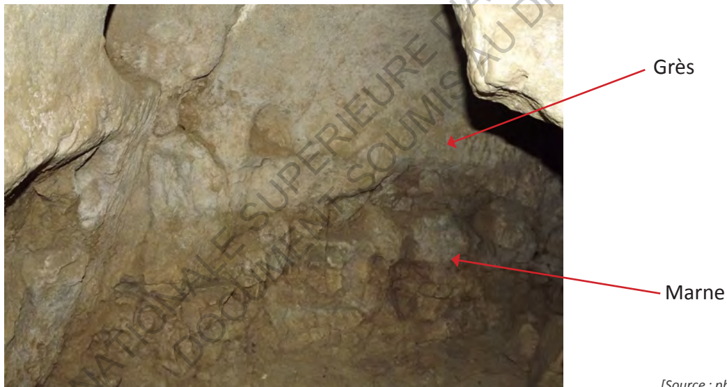
Figure 32 : Localisation de la marne et du grès dans le souterrain
