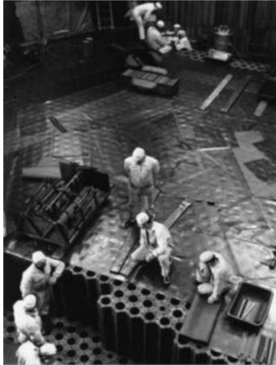
*Figure 5 : Empilement graphite contenant les éléments combustibles.*
