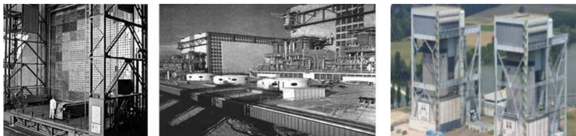
Figure 60 : Photos des réacteurs nucléaires graphite-gaz situés à Marcoule, G1 et G2 (à gauche) et à Saint-Laurent des Eaux, SLA1 et SAL2 (à droite).
