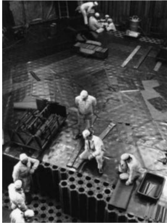
Figure 5 : Empilement graphite contenant les éléments combustibles.
