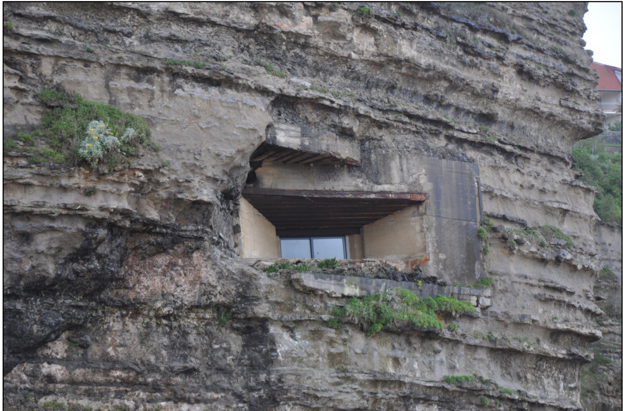
Figure 40 : embrasure de tir de la batterie souterraine de la Pointe Saint-Martin. (Photo A. Quereilhac)
