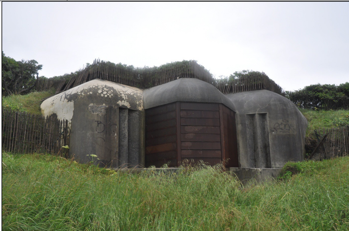
Figure 40 : casemate pour canon de 105mm. (Photo A. Quereilhac).
