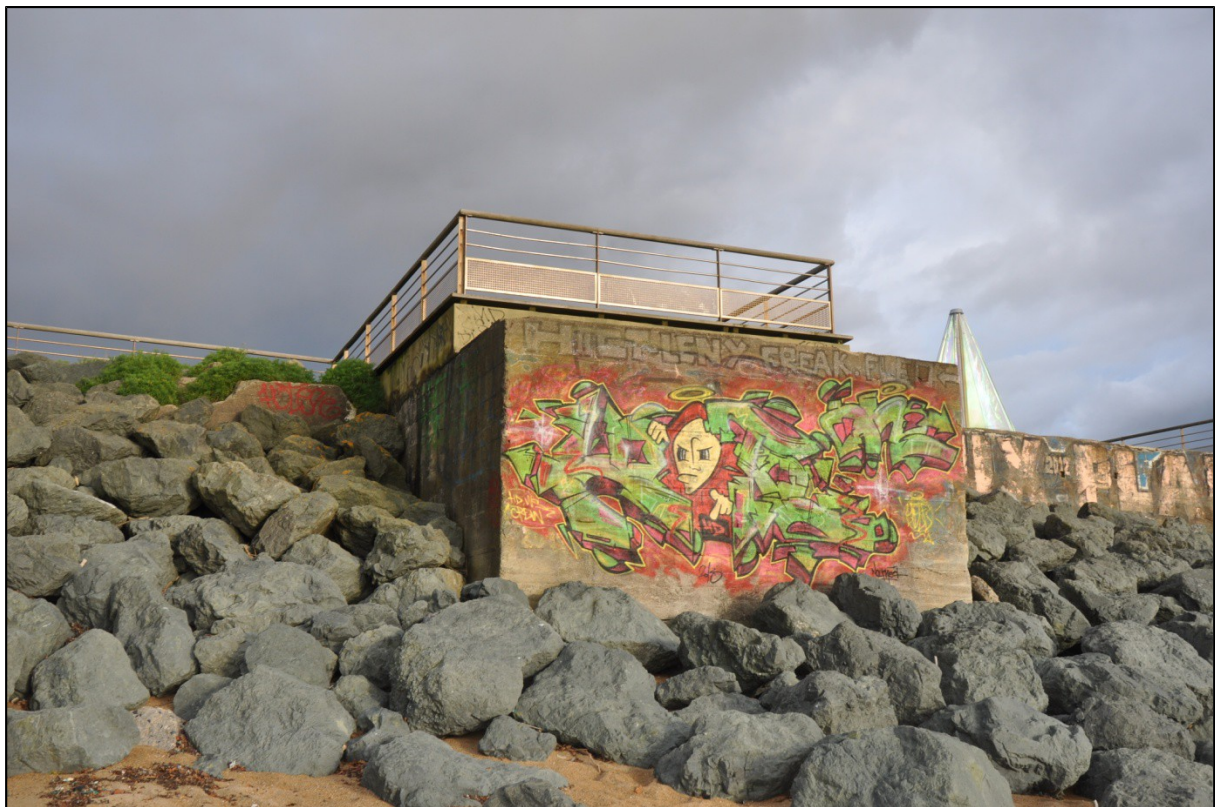
Figure 62 : soute à munitions, batterie de l'hippodrome, plage de la Barre. (Photo A. Quereilhac)
