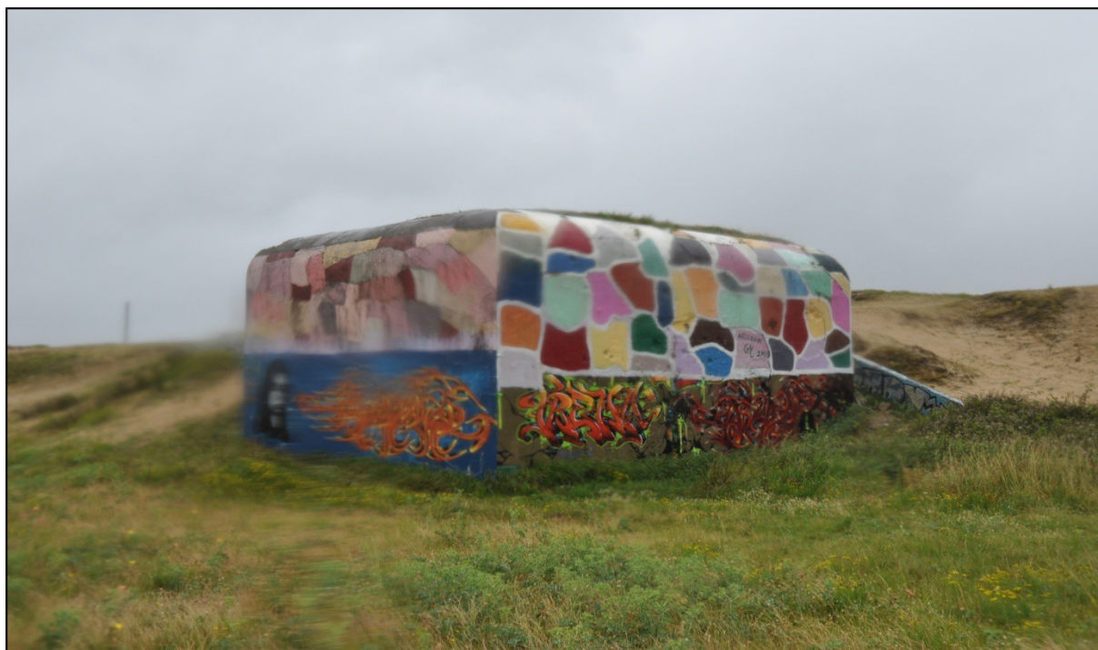
Figure 71 : Soute à munitions de la batterie de Boucau. (Photo A. Quereilhac)
