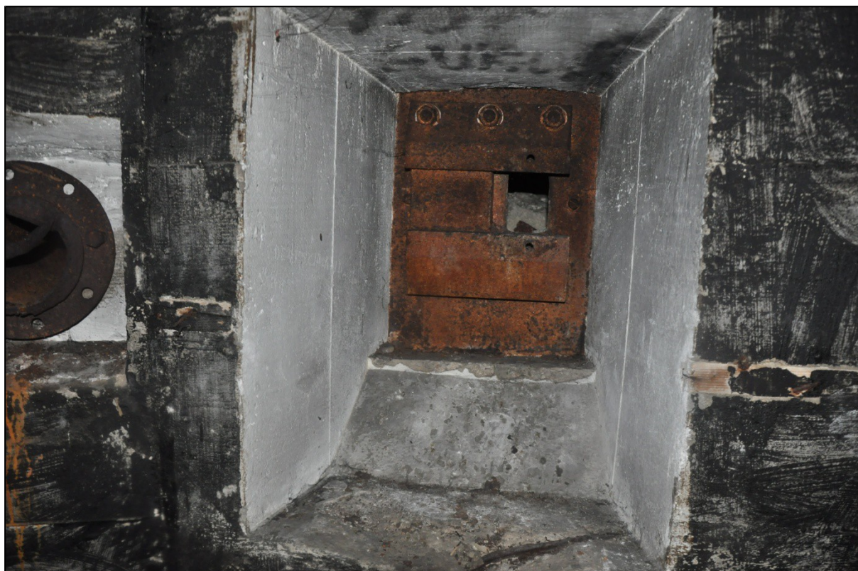
Figure 43 : fenêtre de tir blindée, intérieur du poste de direction de tir. (Photo A. Quereilhac)
