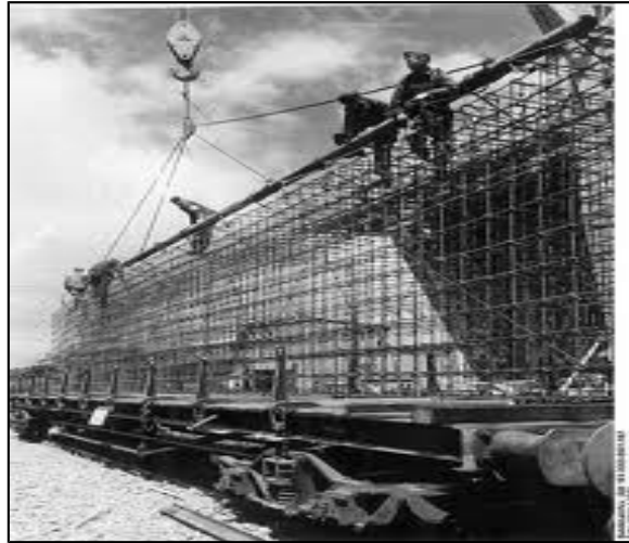
Figure 27, ferrailage de soute à munitions. (Source : DDAY-OVERLORD.COM).
