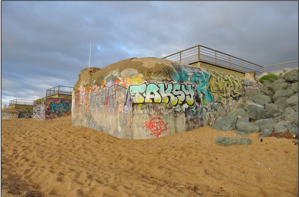
Figure 63 : soute à munitions, batterie de l'hippodrome, plage de la Barre. (Photo A. Quereilhac)
