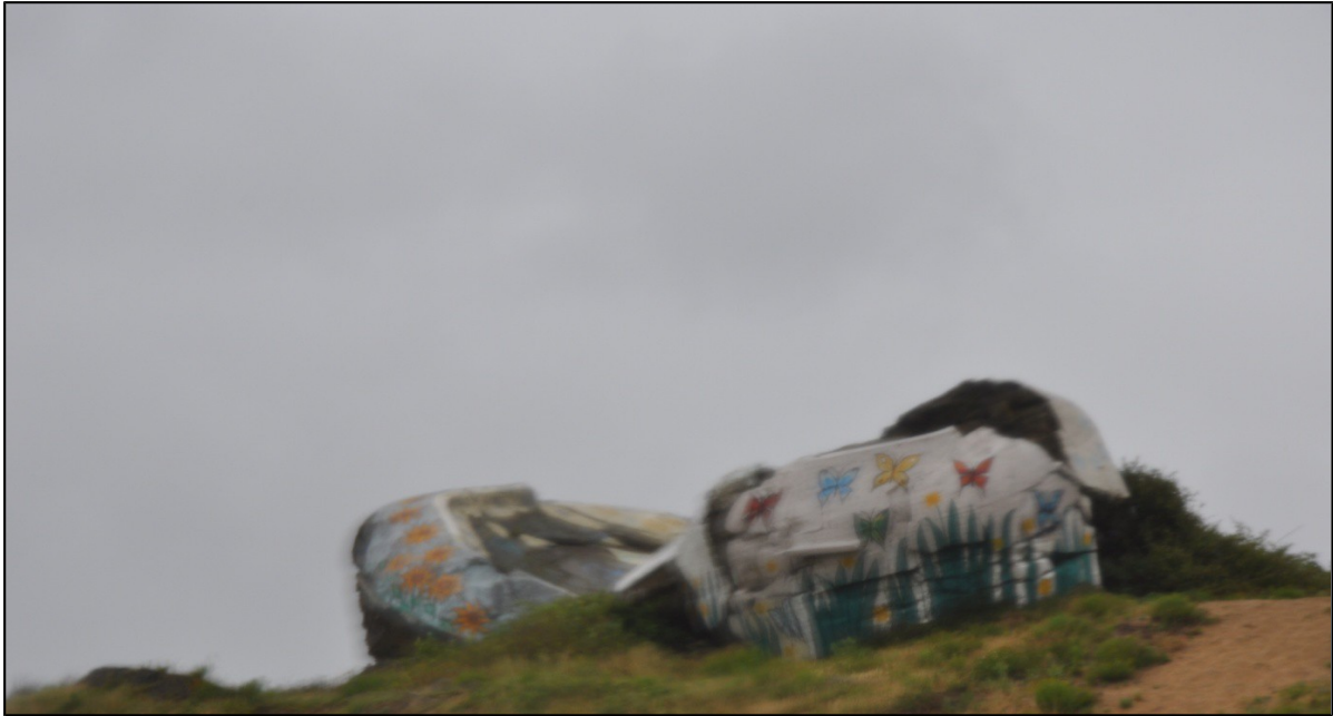
Figures 68 et 69 : vestiges des casemates pour canons de 150mm. (Photo A. Quereilhac)
