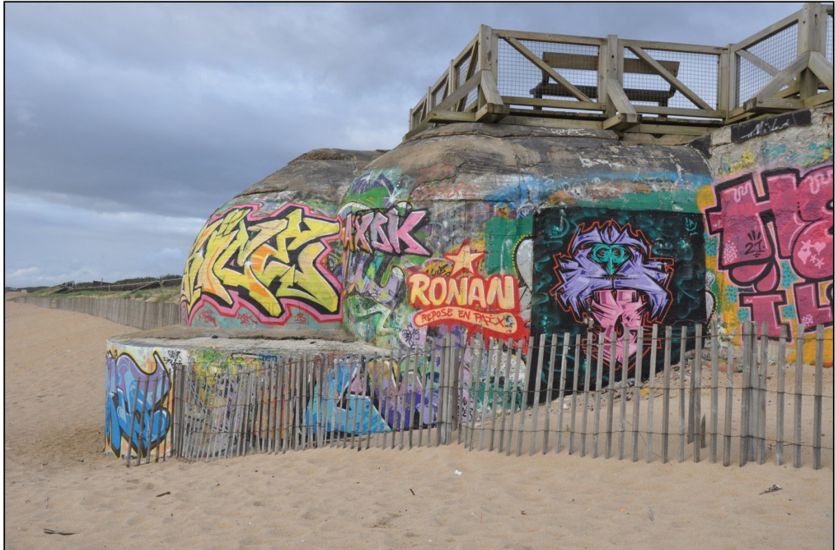
Figure 61 : Poste de direction de tir de type H 636, plage des Sables d'Or. (Photo A. Quereilhac)
