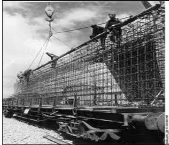
**Figure 27, ferrailage de soute à munitions. (Source : DDAY-OVERLORD.COM).**
