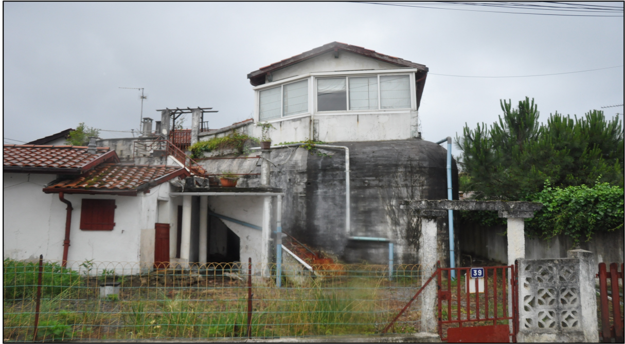
Figure 24 : habitation sur casemate ; 26, chemin Erromardie. (Photo A. Quereilhac)
