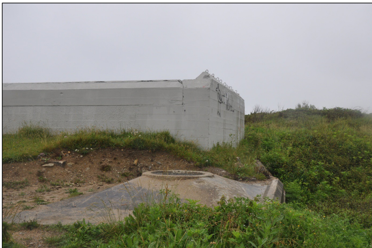
Figure 36 : casemate avec vue sur le Tobrouk. (Photo A. Quereilhac).
