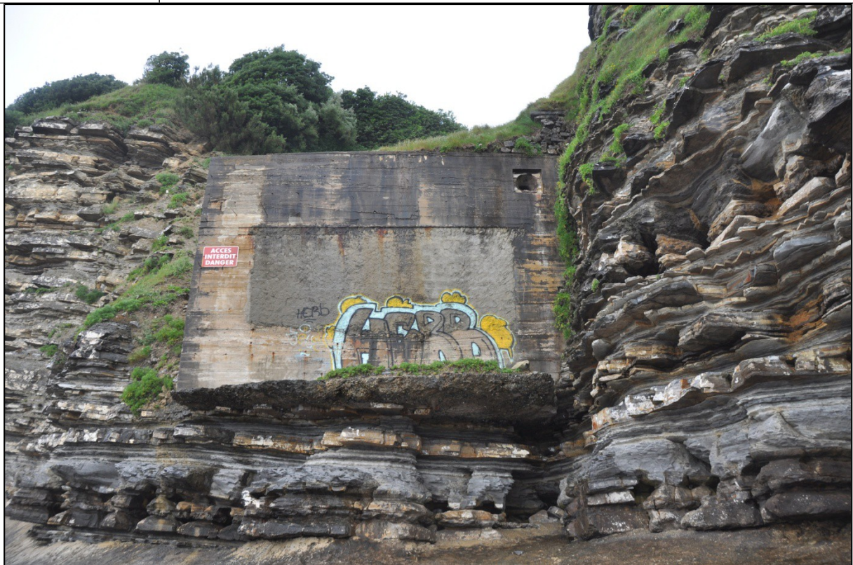
Figure 37 : embrasure de tir de la batterie souterraine de Sainte-Barbe. (Photo A. Quereilhac)
