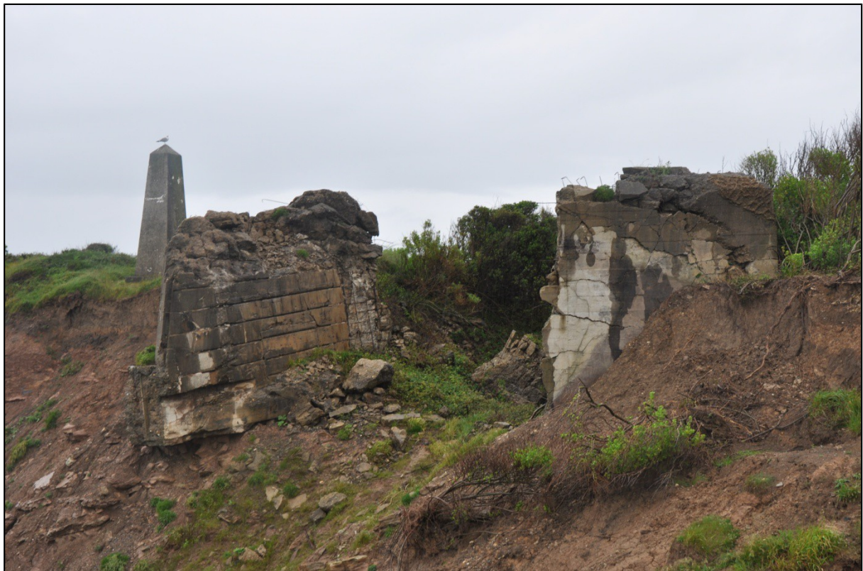
Figure 29 : casemate H669 (photo : A Quereilhac)
