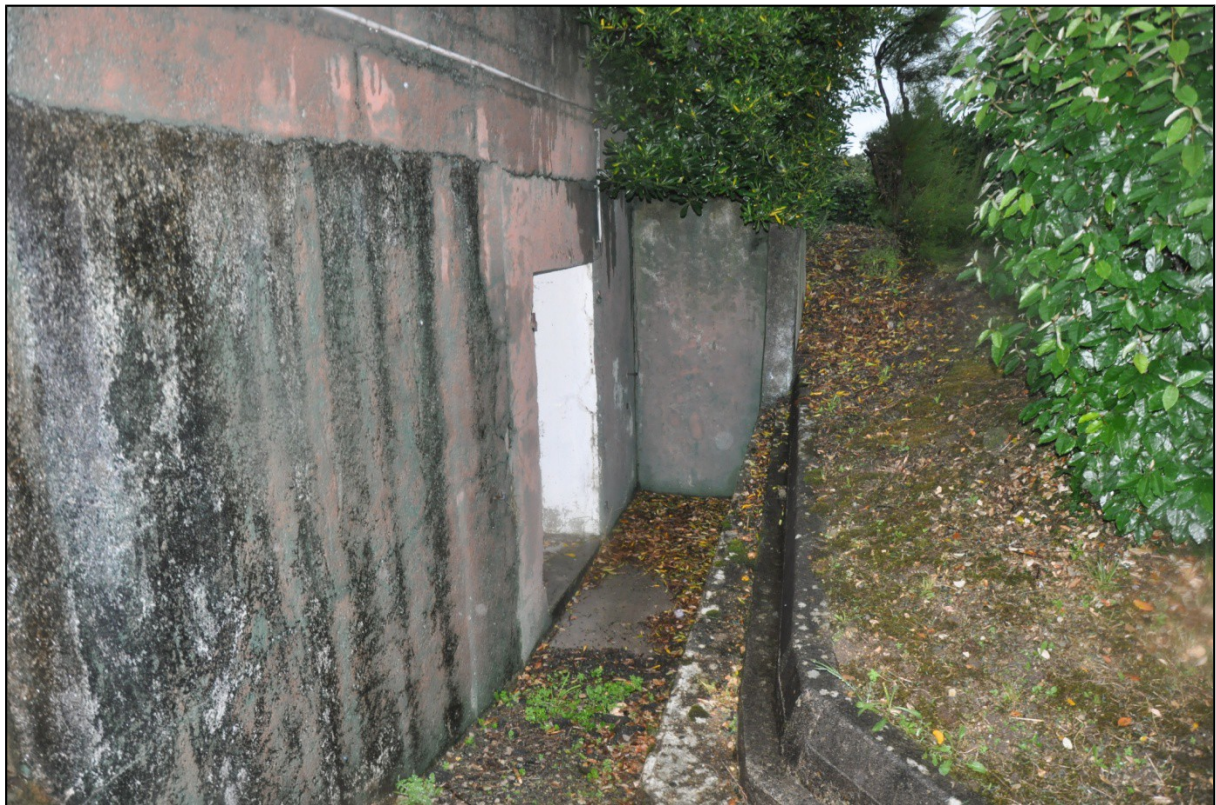
Figure 45: vue arrière du poste de direction de tir de la batterie d'Erromardie. (Photo A. Quereilhac)
