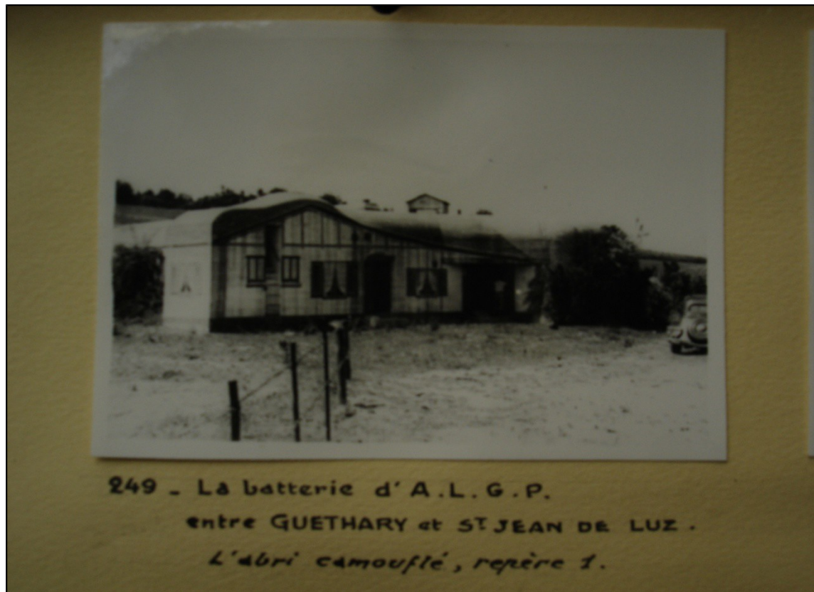
Figure 20 : batterie d'A.L.G.P. abri camouflé entre Guéthary et Saint-Jean-de-Luz. (Source : SHD).
