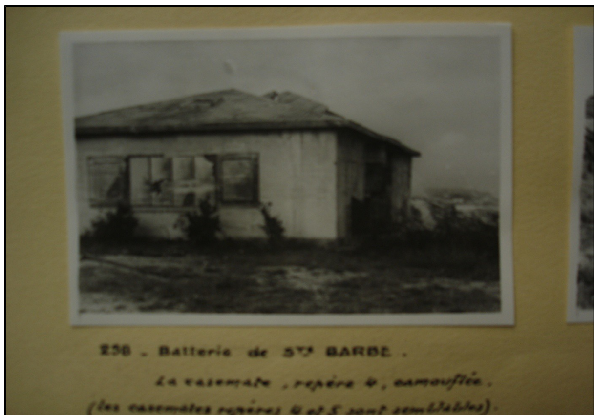
Figure 21 : Casemate camouflée, Batterie de Sainte-Barbe, Saint-Jean-de-Luz. (Source : SHD).
