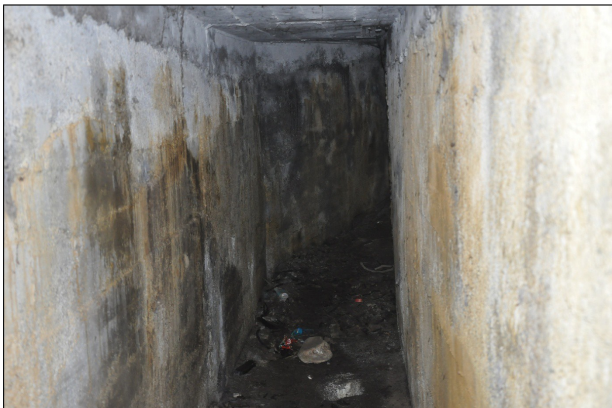
Figure 47: galerie souterraine pour la circulation des soldats, batterie d'Erromardie. (Photo A. Quereilhac)
