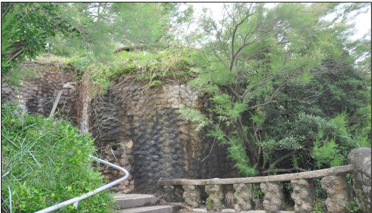
Figure 57: casemate assurant la défense arrière du PC. (Photo: A. Quereilhac)
