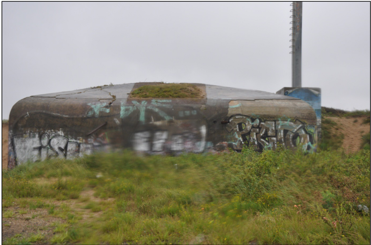
Figure 70 : Soute à munitions de la batterie de Boucau. (Photo A. Quercilhac)
