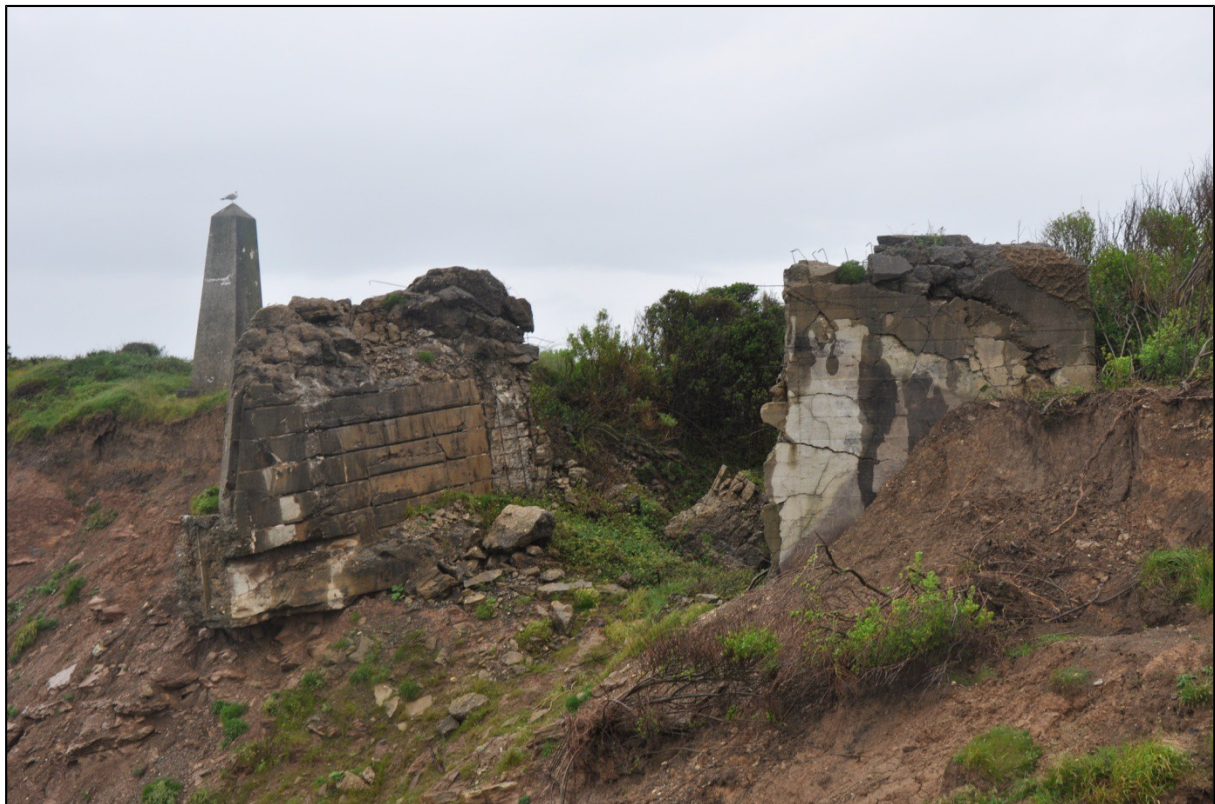
Figure 29 : casemate H669 (photo : A Quereilhac)
