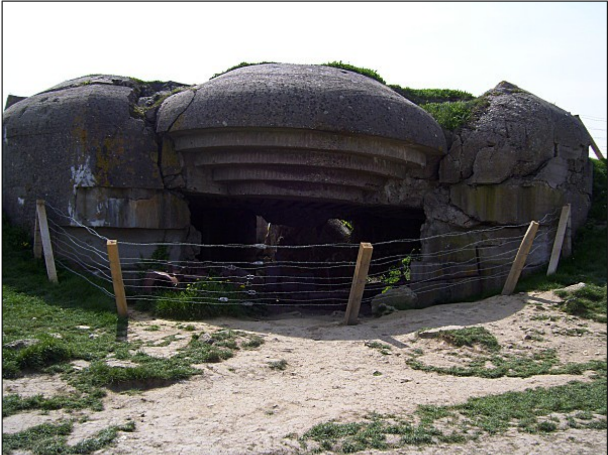
Figure 82 : casemate pour pièce de 150, Batterie de Longues sur Mer. (Source : vestigesdeguerre.blog.fr ).
