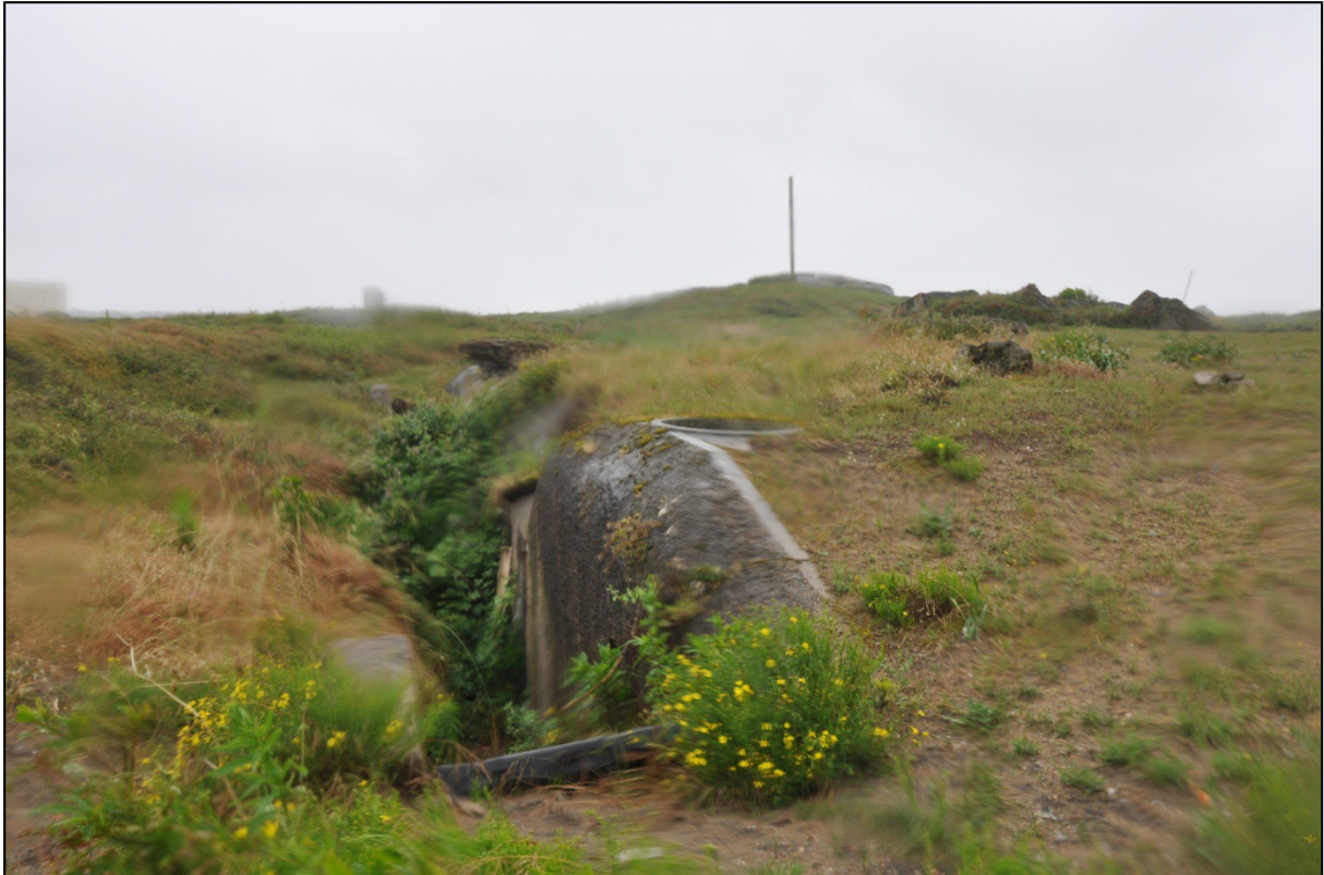
Figure 73 : abri pour personnel avec Tobrouk de défense rapprochée, batterie de Boucau. (Photo A. Quereilhac)
