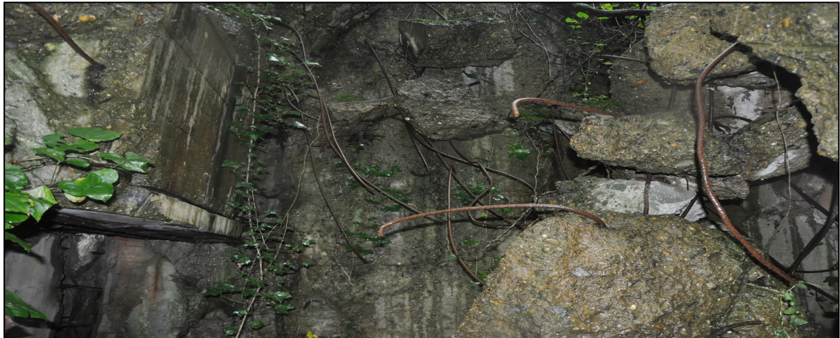
Figure 26 : Ferrailage de casemate, Hendaye, château d'Abbadia. (Photo A. Quereilhac)
