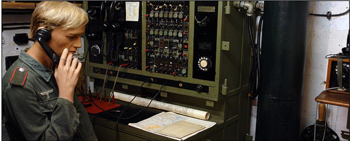
Figure 76 : Salle des transmissions. (Source : http://www.musee-grand-bunker.com/index.asp ).
