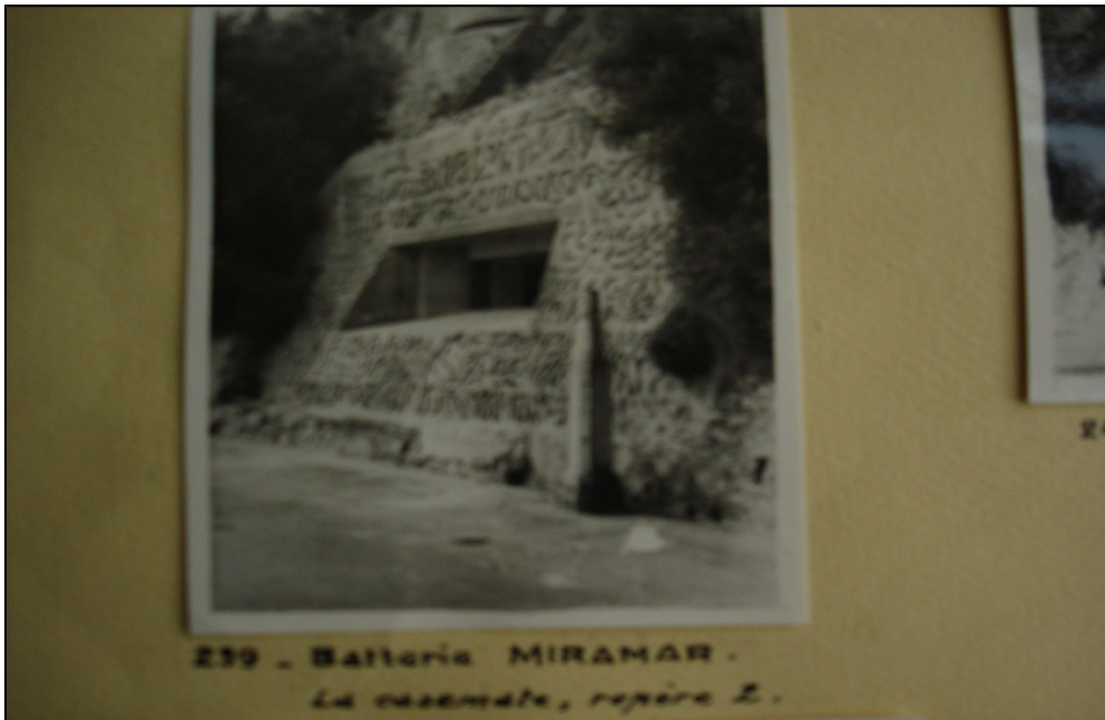
Figure 11 : casemate pour mitrailleuse, batterie Miramar, Biarritz (source : SHD).
