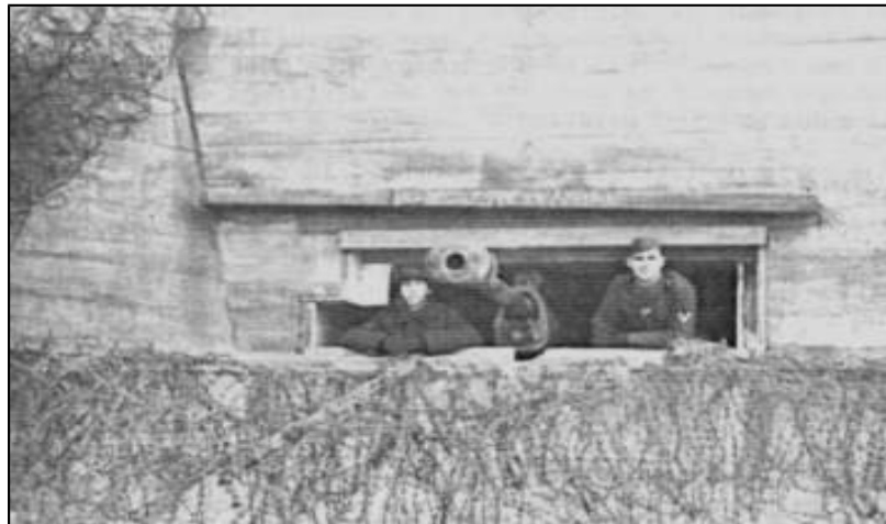
Figure 12 : Casemate type 680 pour canon anti-char PAK. (Source : users.skynet.com.)
