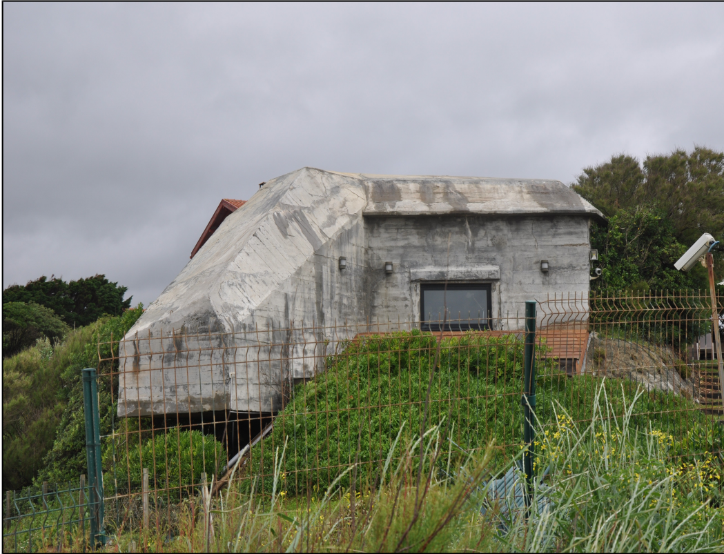
Figure 25 : Casemate de flanquement H680. (Phot A. Quereilhac)
