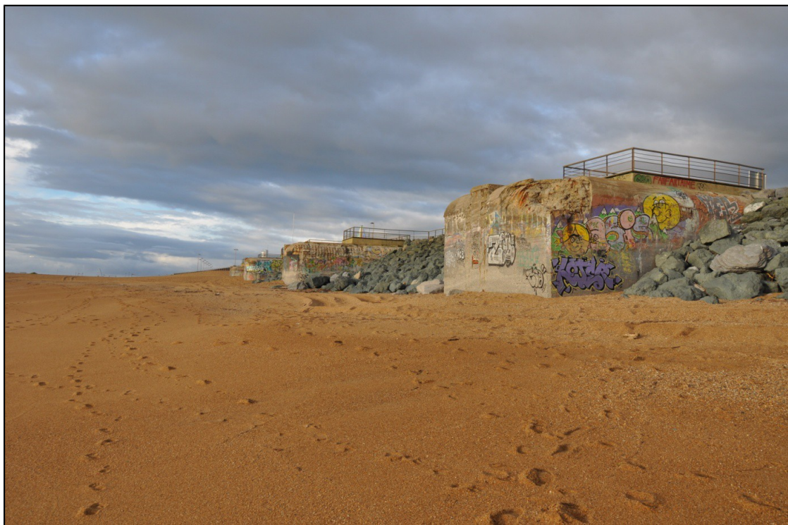
Figure 64 : vue d'ensemble des soutes à munitions, batterie de l'hippodrome, plage de la Barre. (Photo A. Quereilhac)
