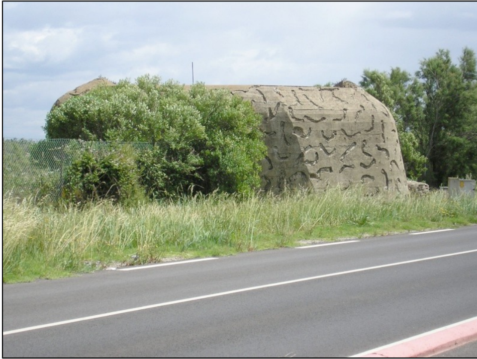
Figure 19 : camouflage sur le front de la casemate (source : http://sudwall.superforum.fr/ )
