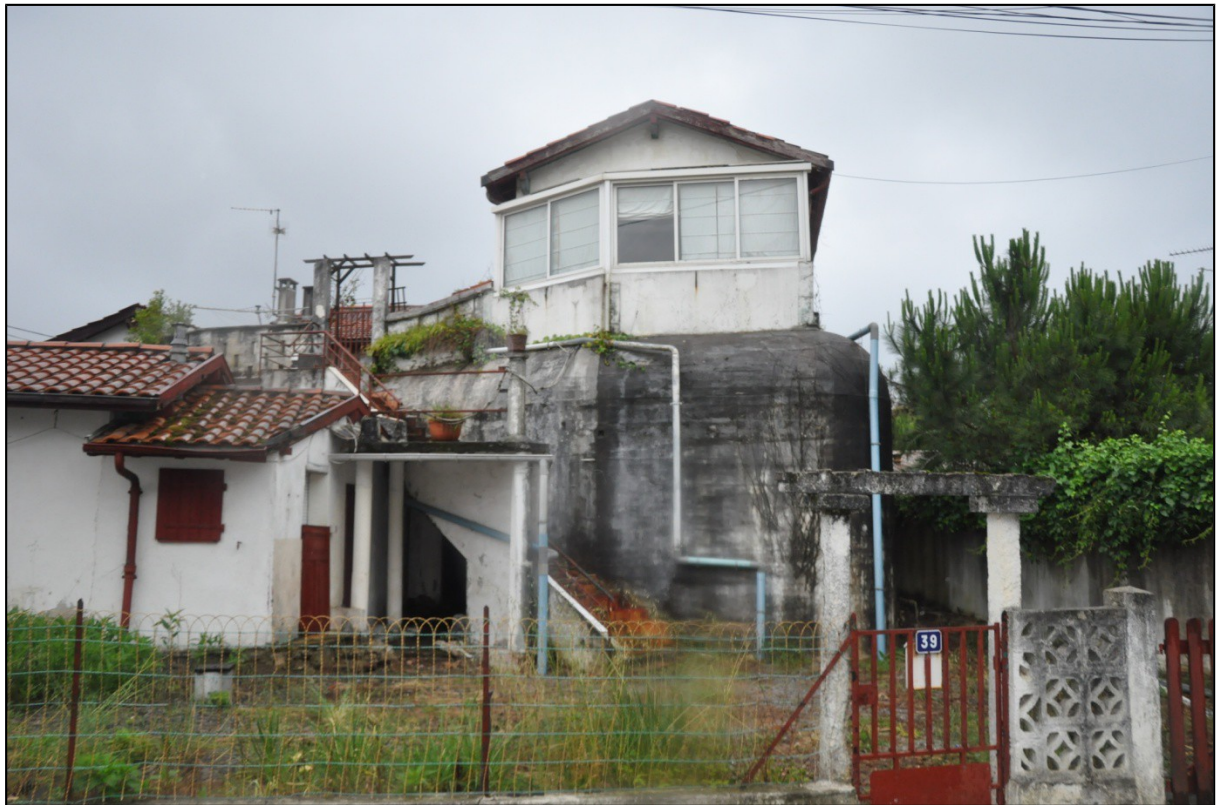
Figure 48 : soute à munitions sous une habitation de la rue Iratzia. (Photo A. Quereilhac)
