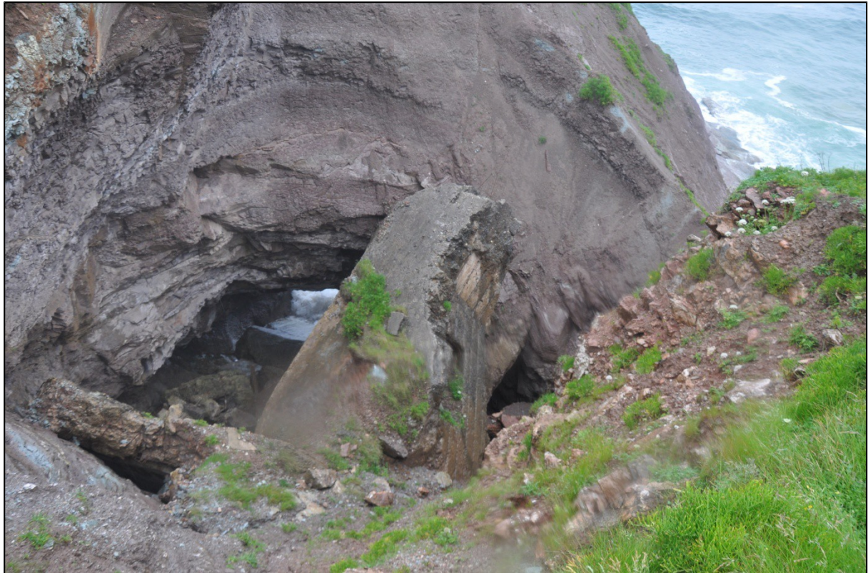
Figure 30 : casemate H 669 (photo : A. Quereilhac)
