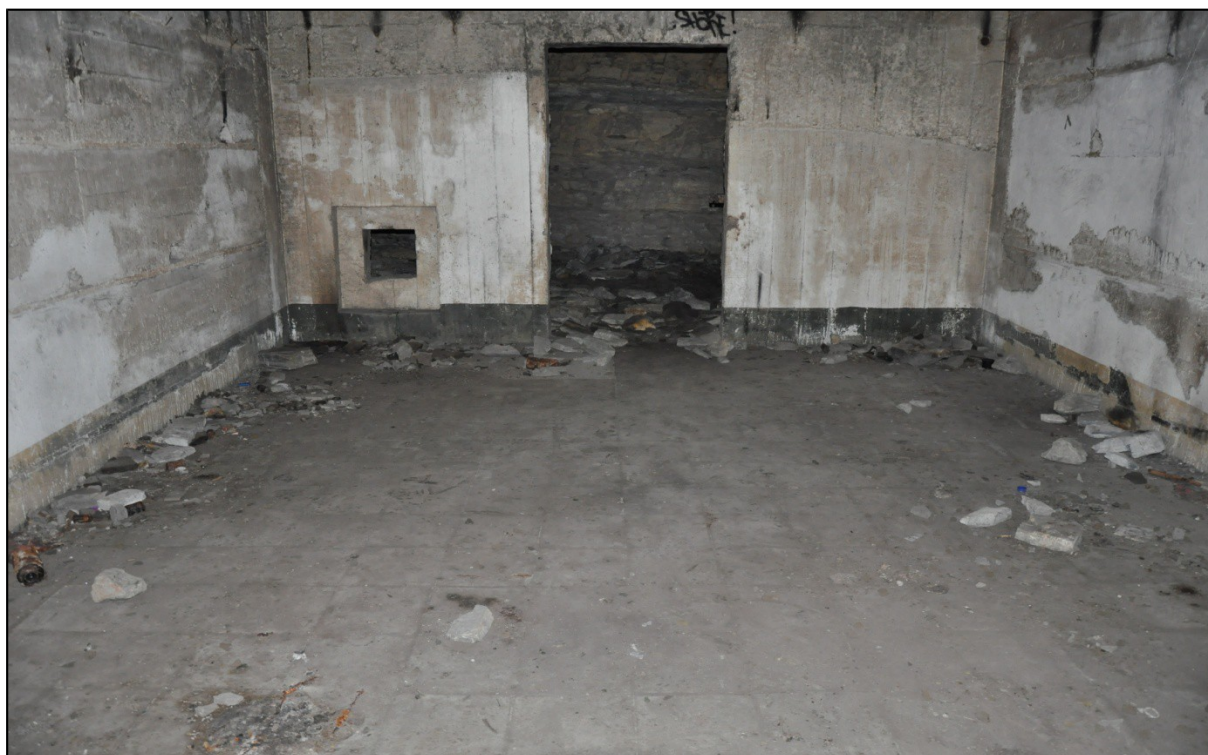
Figure 39 : chambre de logement des artilleurs. (Photo A. Quereilhac)
