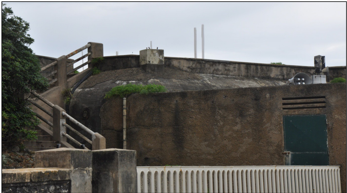
Figure 58 : casemate d'artillerie sous l'hôtel du Palais. (Photo: A. Quereilhac)
