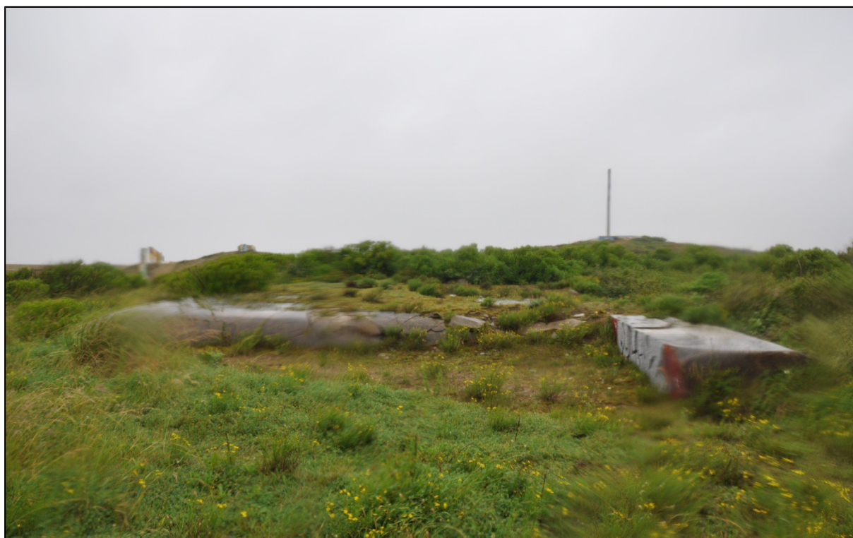
Figure 72 : abri pour personnel de la batterie de Boucau. (Photo A. Quereilhac)
