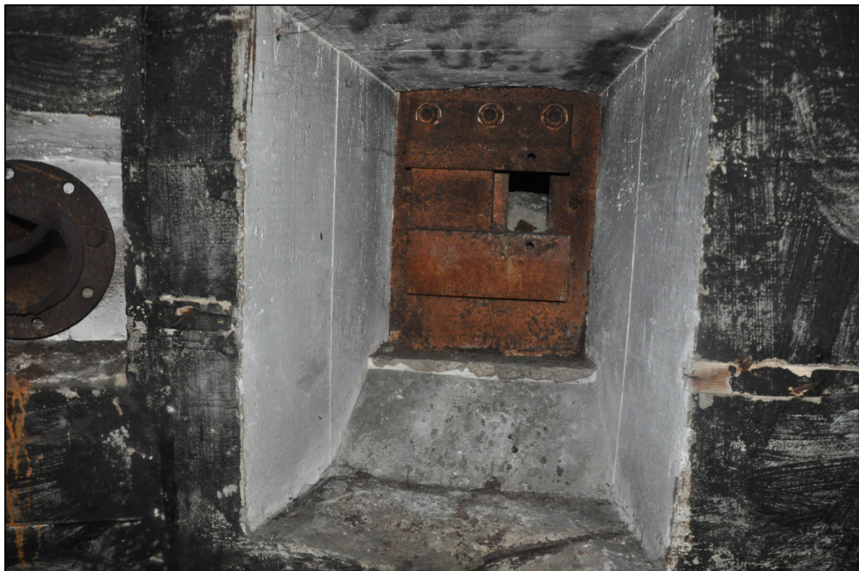
Figure 43 : fenêtre de tir blindée, intérieur du poste de direction de tir. (Photo A. Quereilhac)
