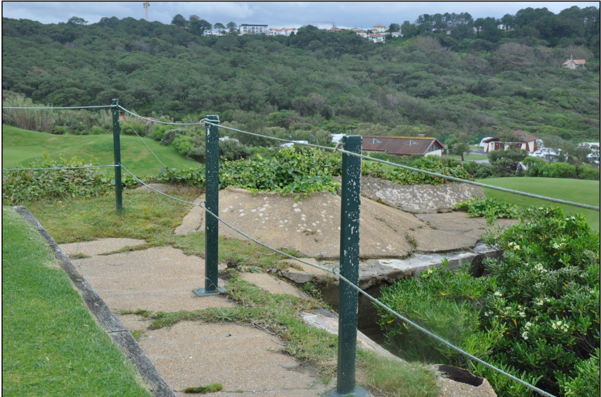
Figure 53 : casemate de flanquement de la batterie de Marbella, vue du Tobrouk. (Photo A. Quereilhac)
