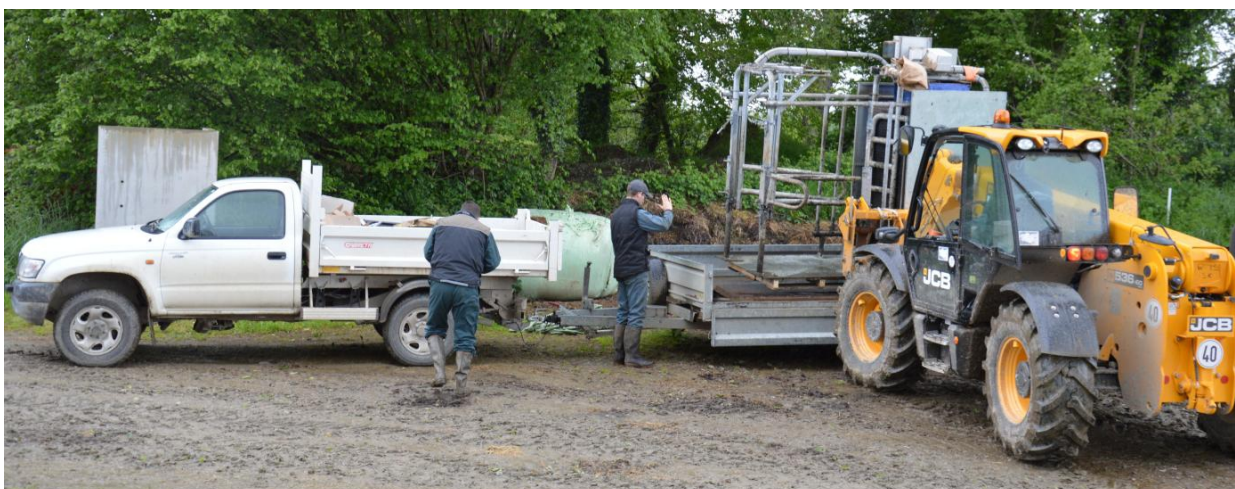
Figure 4 – Pose de la porte de tri avec le télescopique sur le plateau,
