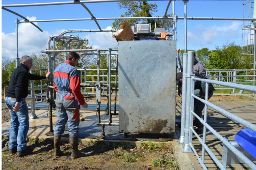
Figure 7 – Remise en place de la porte de tri à la sortie de l'aire d'attente
