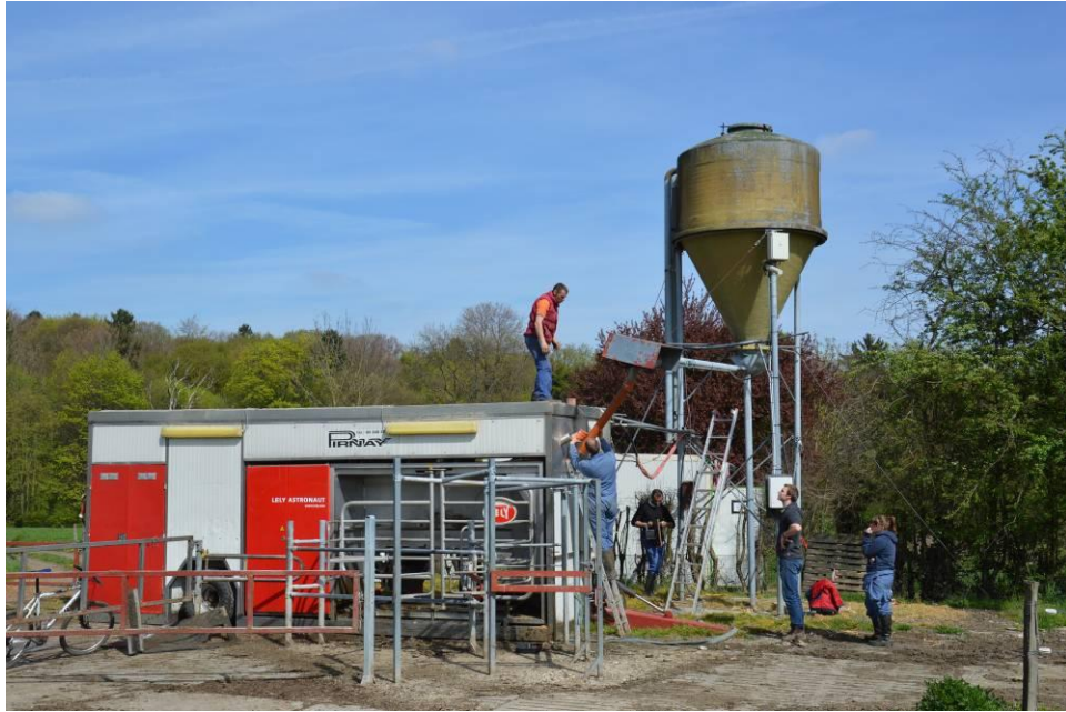
Figure 6 – Remise en place du silo,
