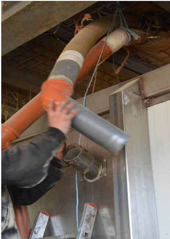
Figure 2 – Débranchement du silo de concentrés.
