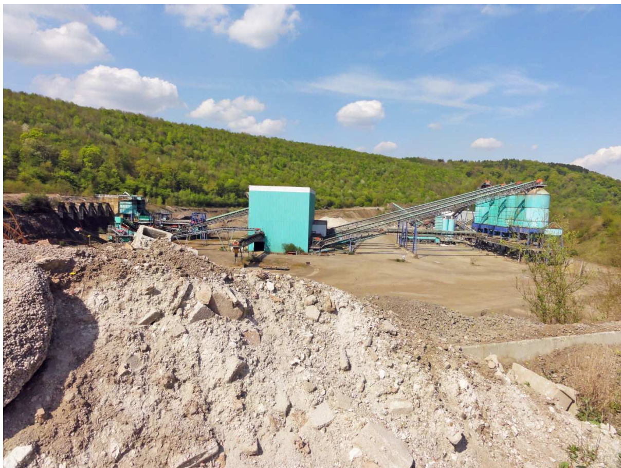
Photo 11 : L'usine de la SLAG vue depuis le crassier la surplombant ; photographie orientée Nord (M. Picon 2014)
