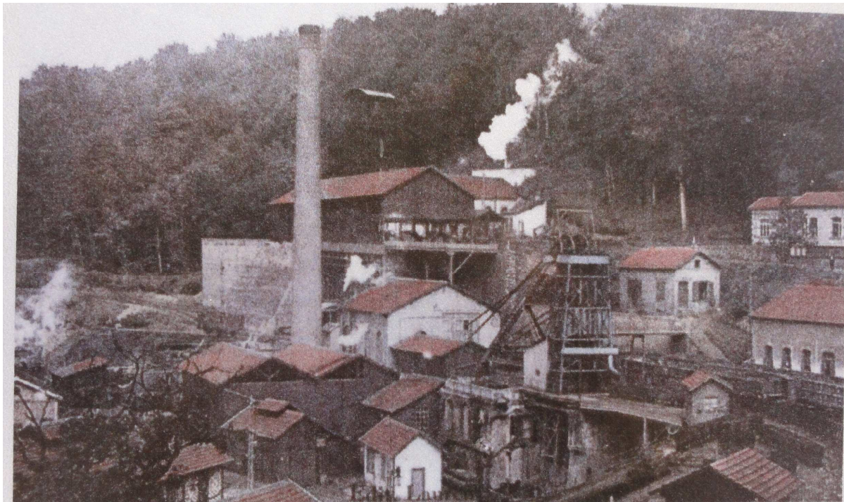
La mine du fond de la Noue.
