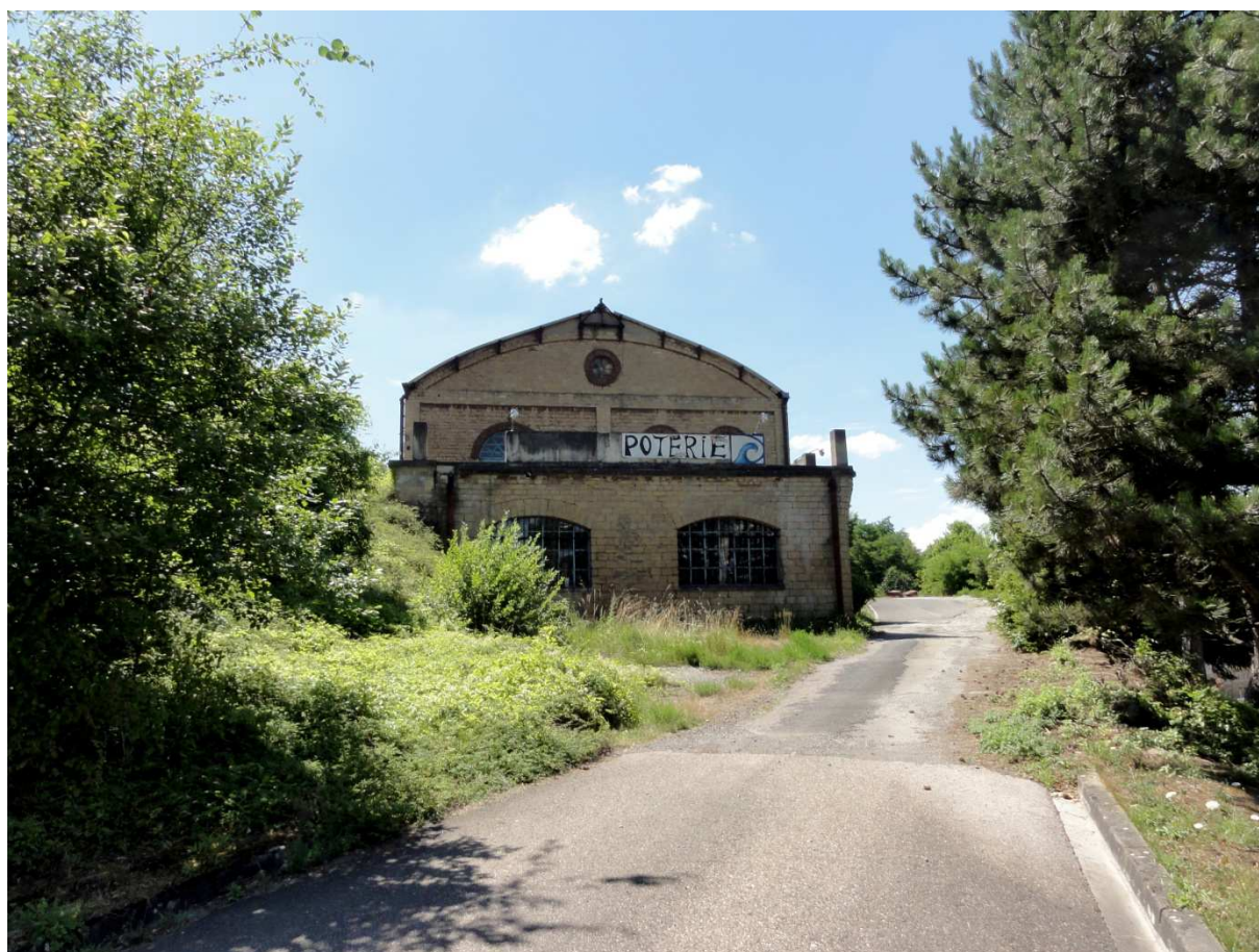
Photo 24 : l'annexe de la centrale transformée en poterie artistique (M. Picon 2014)
