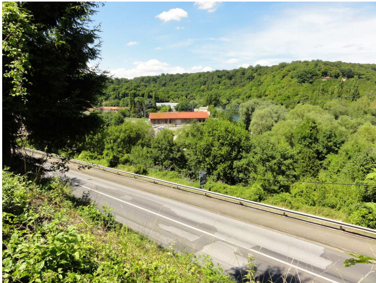
Photo 25 : l'ancienne station de pompage d'Homécourt au toit vouté (M. Picon 2014)
