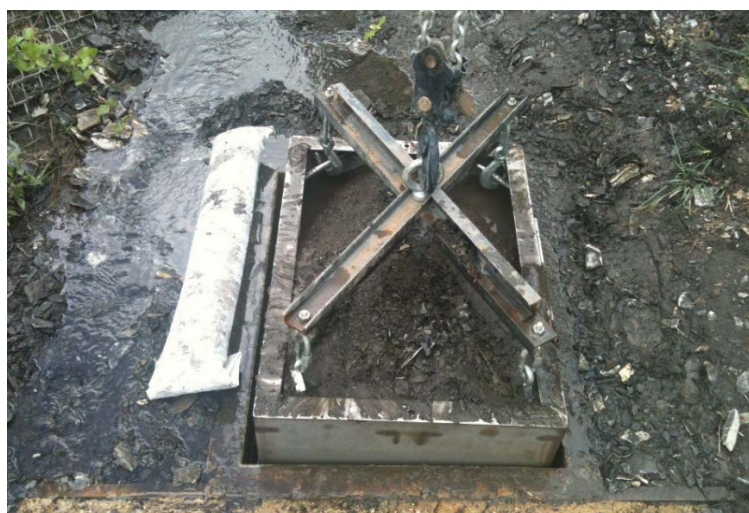
Figure 13: Dérivation de l'écoulement en rive droite lors d'une vidange de la trappe
