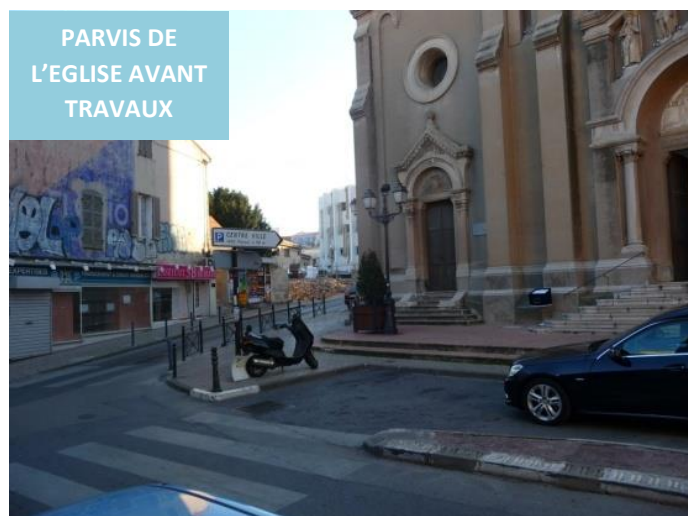
Figure 27 : Le parvis de l'église avant les travaux
