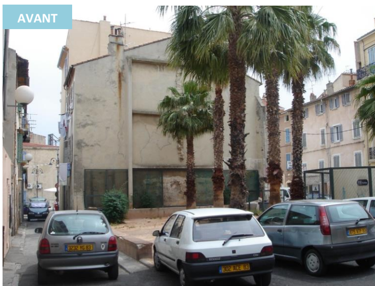
Figure 43 : La place Bourradet avant les travaux
