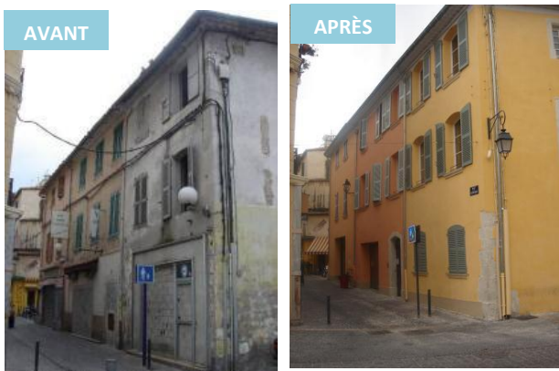
Figure 40 : Maison de l'habitat avant et après intervention _ Rue de la République
