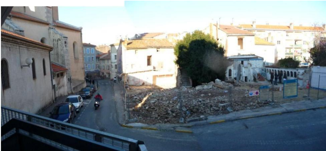
Figure 23: Îlot Martini après la démolition
