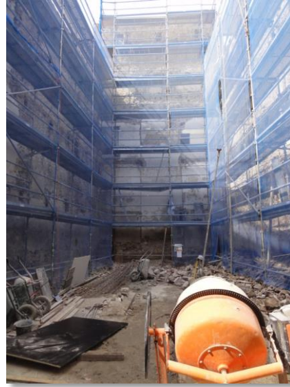
Figure 16 : Phase de démolition
