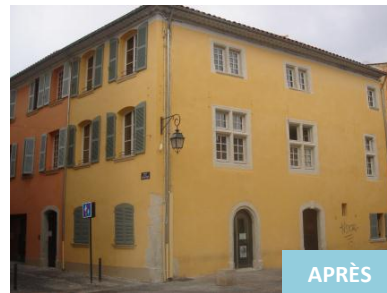
Figure 41 : Maison de l'habitat avant et après travaux donnant sur la place Bourradet
