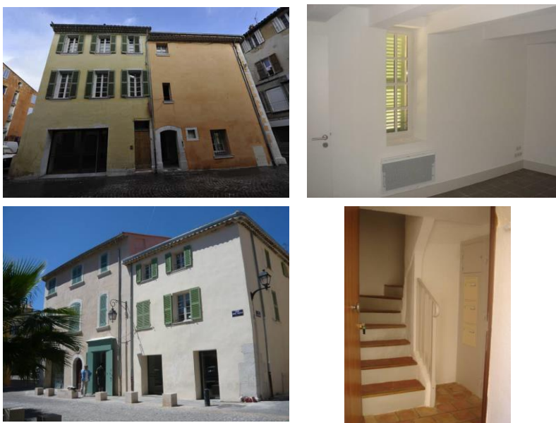
Figure 42 : Logements d'urgence avant et après travaux (1 rue Evenos - 10 rue Clément Daniel)
