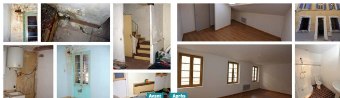
Figure 7 : L'habitat dégradé avant et après la réhabilitation
