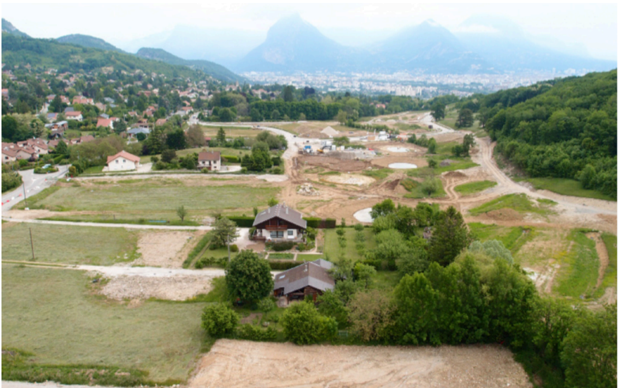
Figure 12 : photo aérienne du site pendant les travaux d'aménagement du parc naturaliste. Source : Egis géotechnique.
