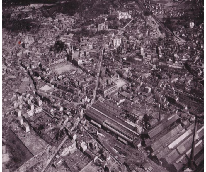
Figure 9 : La RN 88, traversant la ville de Saint Chamond.
