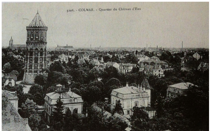
Le Château d'eau de Colmar
