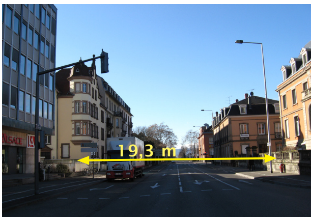
La route de Rouffach (RD 30) axe traversant Nord-Sud.
