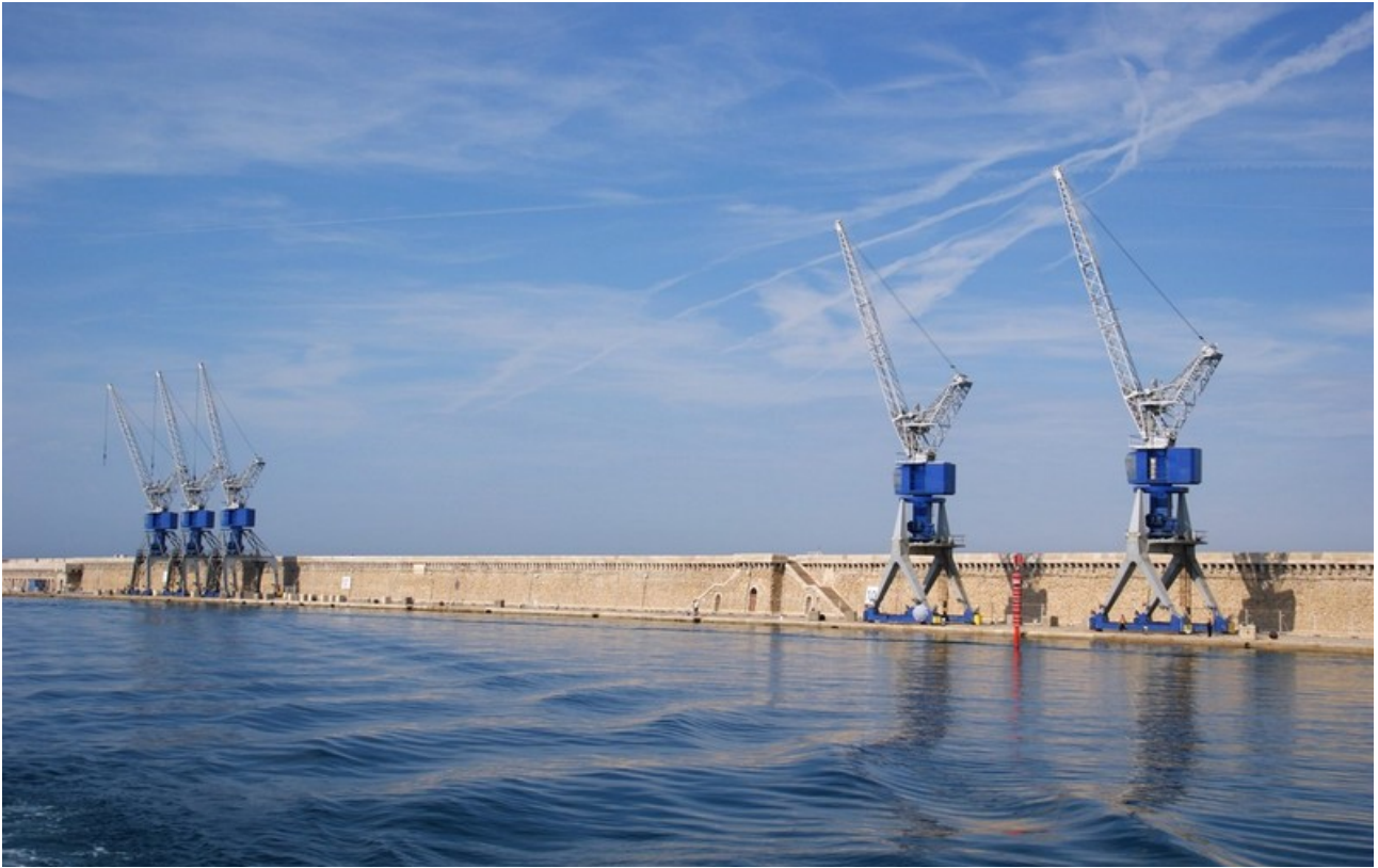
Figure 5 : la digue du large vue du port (photo Frédéric D. - photos-provence.fr)
