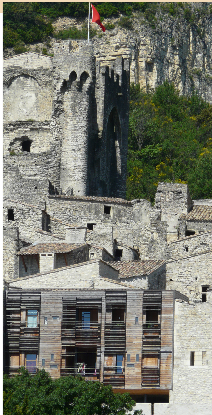
Village médiéval de Cruas, réhabilitation d'un îlot expérimental par P. Donjerkovic (mission d'accompagnement de la commune par le CAUE 07 pour la faisabilité et le recrutement du maître d'œuvre).
