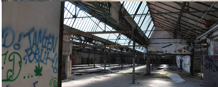
La dimension architecturale est prégnante sur ce site et guide les choix en matière de mise en valeur, CAUE 07, 2013
