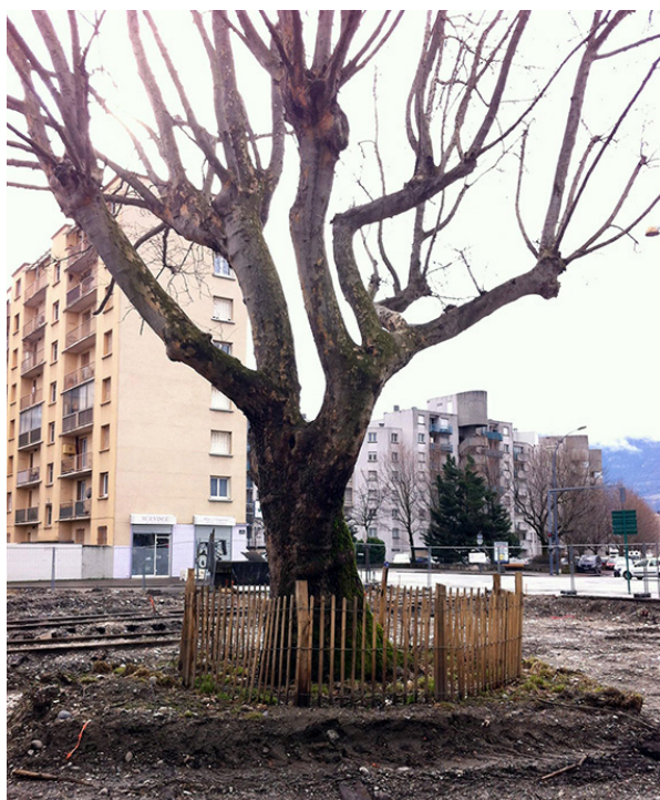
Figure 79/ Exemple de protection du tronc sur le chantier de la ZAC Flaubert à Grenoble.
