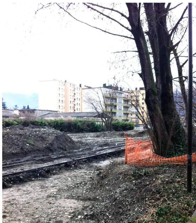
Figure 80/ Exemple de protection du tronc insuffisante sur le chantier de la ZAC Flaubert à Grenoble.
