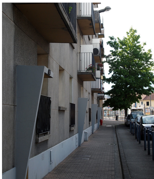
Figure 70/ Un arbre planté trop près de la façade, avenue Ambroise Croizat
