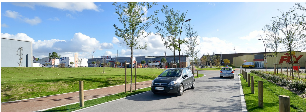
Photographie 15 : Aire des Moissons, Saint-Parres-aux-Tertres, après requalification Source : www.frey.fr
