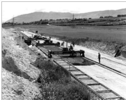
Photographie 15 : Construction réseaux
