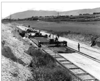
Photographie 15 : Construction réseaux
