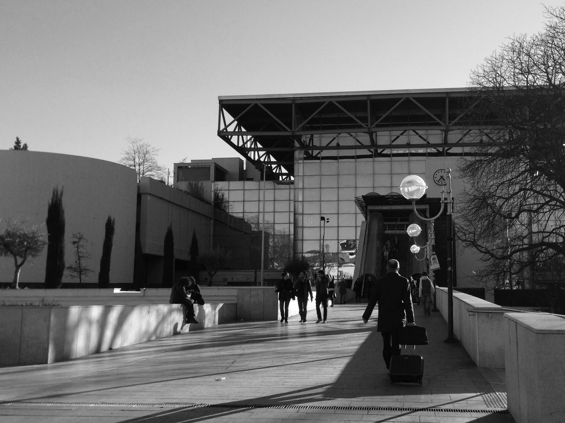
Le centre d'échange de Perrache vue depuis la place Carnot. Crédit Photo MéliSSande Miagkoff 2014 «Monter pour redescendre».
