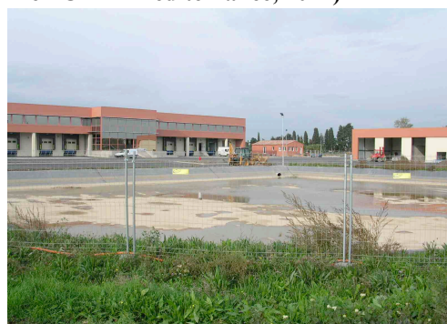
Photo 6 Écopôle (Source : CEREMA, ex-CETE méditerranée, 2012)
