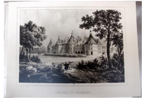
Vue de la façade du château
