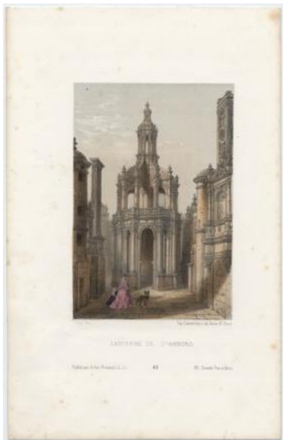
Chambord : lanterne du château, qui termine le grand escalier
