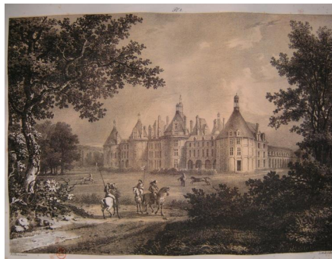
Vue de la façade du château
