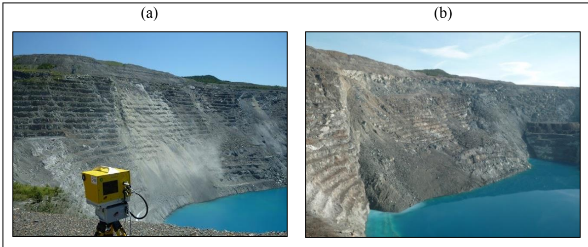
Figure 6 : Photo du mur est (a) avant le glissement (11 juillet 2012) et (b) après glissement (2 août 2012)
