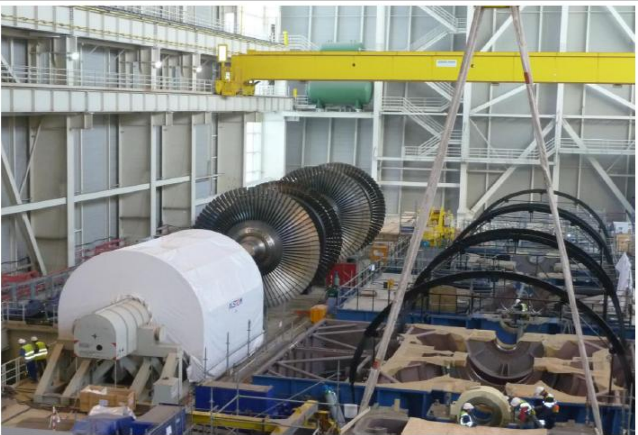
Fig. 6 : Turbine Arabelle sur le chantier de Flamanville 3
