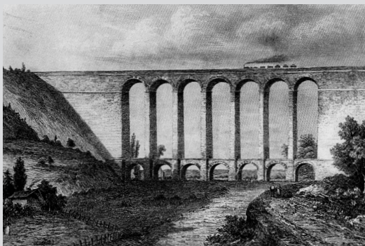
Le viaduc de Val-Fleury , 1855. 67
