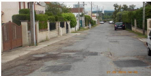
Illustration 47 : Rue Utrillo, lotissement de Comtesse _ Source : Photo personnelle.
