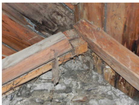
Fig. III.50 – Exemple d'assemblage avec un jeu important, Église Saint Gervais et Saint Protais , Saint-Gervais
