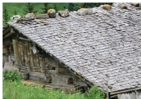
Fig. III.10 – Exemple de couverture en ancelles
