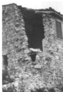
Fig. III.55 – destruction des angles : Château Marchesal, Italie
