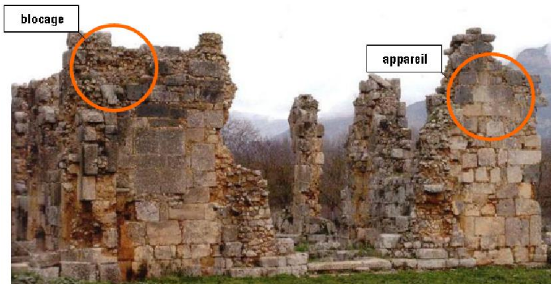
Fig. II.5 – Les deux grands types de maçonnerie, [Oik09]
