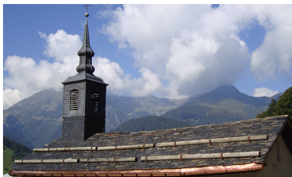
Fig. III.9 – La couverture en ardoises de la chapelle
