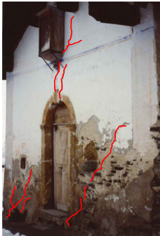
Fig. III.17 – Fissure verticale au-dessus de la porte et endommagement de la maçonnerie en partie basse, 1986, avant restauration, Archives Départementales du STAP
