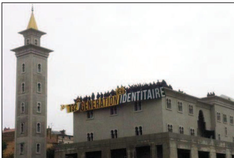
Photographie 2 : L'occupation du chantier d'une mosquée à Poitiers, le 20/10/2012
