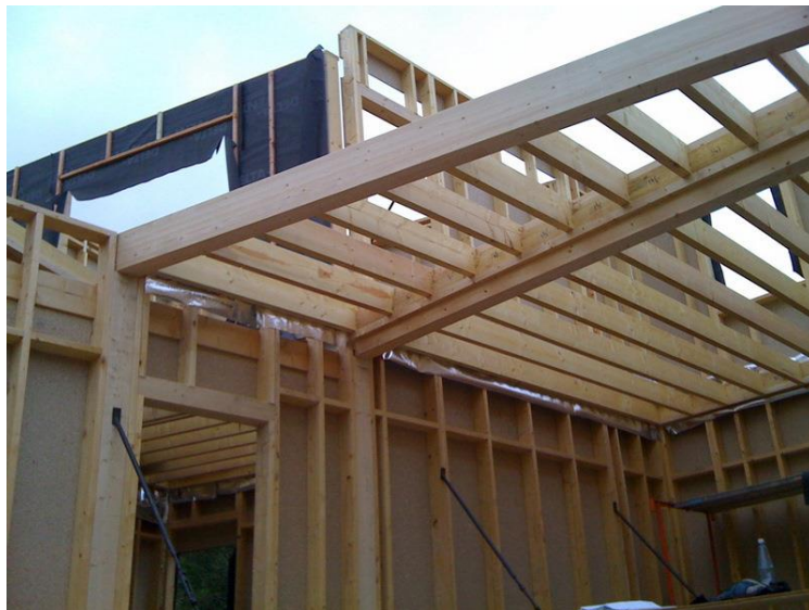
Figure 4 : Assemblage sur chantier d'éléments préassemblés en atelier.
