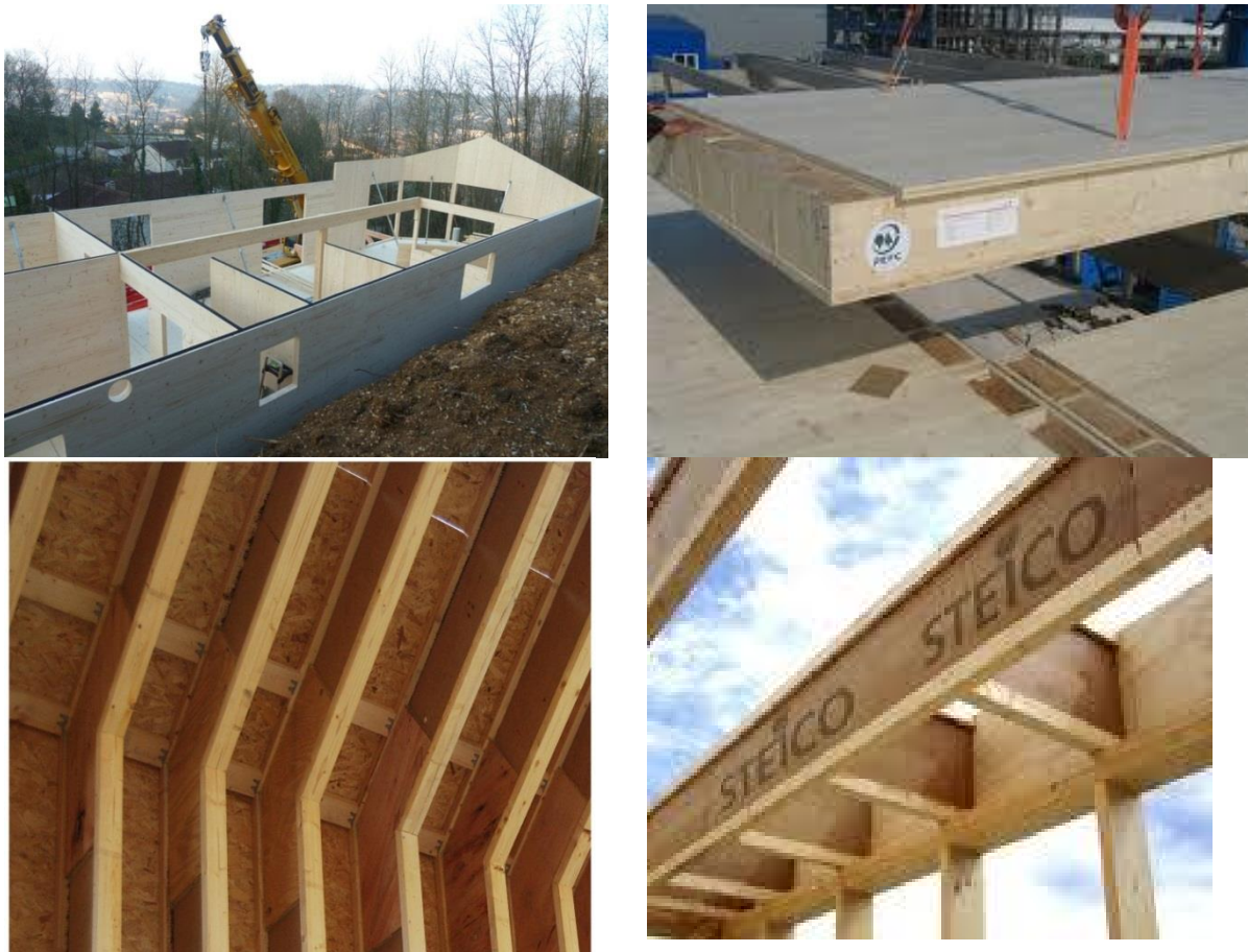
Figure 9 : Systèmes de construction en bois. En haut, système en bois massif laminé. En bas, système de poutrelles ajourées en I (Novatop et Steico).
