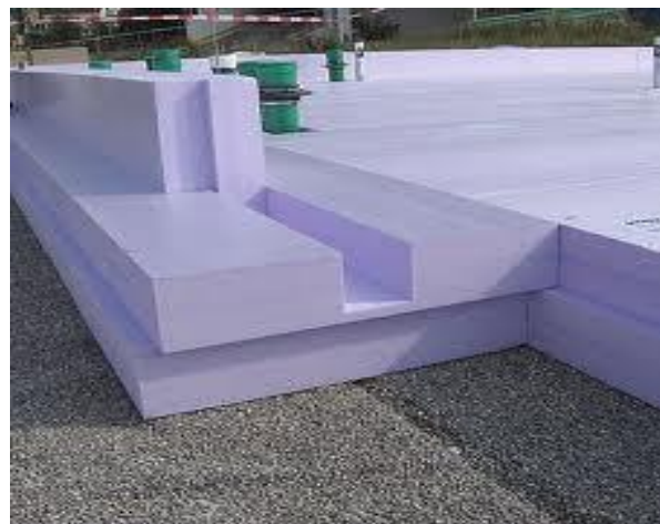
Figure 11 : Panneaux XPS et utilisation de blocs modulables de XPS en isolation sous dalle en coffrage perdu (Dow Corning et Jackodur).
