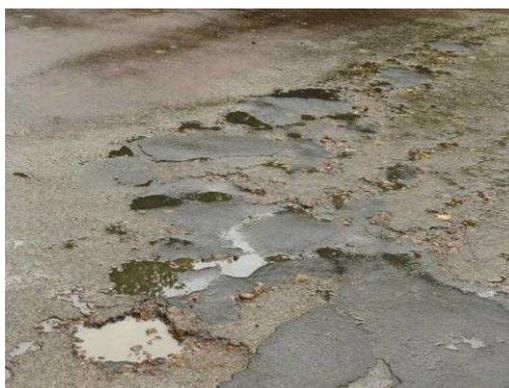
**Figure 96 : Exemple de rétention d'eau sur la voirie en fonction des aspérités / irrégularités**
