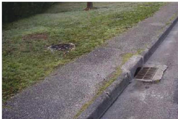
Avaloir conduisant les eaux pluviales de voirie vers le puits d'infiltration – Chassieu 69
