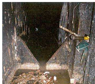
Figure 100 : Déversoir triangle
