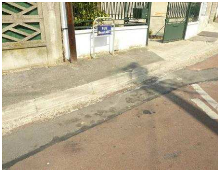
Figure 38 : Exemple de traitement des poteaux électriques pour éviter leur dégradation
