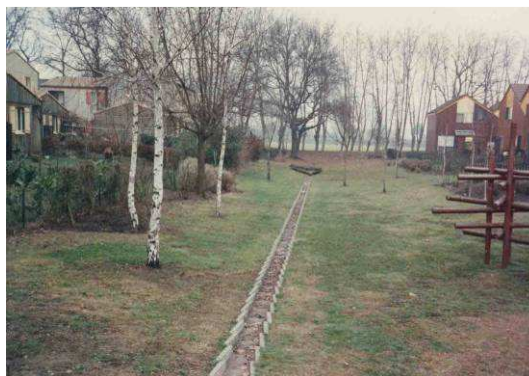
Noue et cunette en béton à Villaboiss Bruges (33) Source CETE du Sud-Ouest
