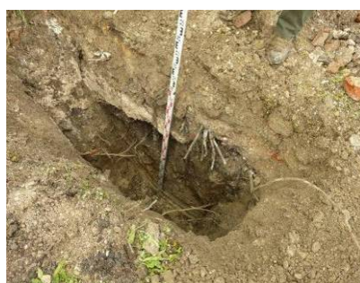
Figure 64 : Terrassement à la pelle mécanique pour identifier la pénétration du colorant
