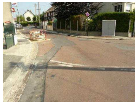
Figure 39 : Phénomène de déformation de la chaussée en fonction de l'influence de la nappe
