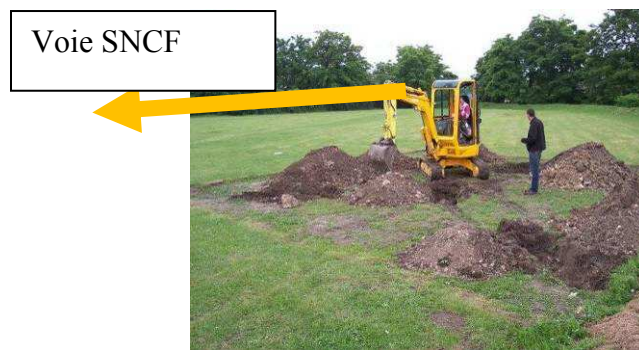
Figure 65 : Terrassement pour identifier la présence de colorant
