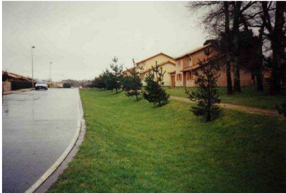
Principe de fonctionnement d'une noue ou d'un fossé d'infiltration
