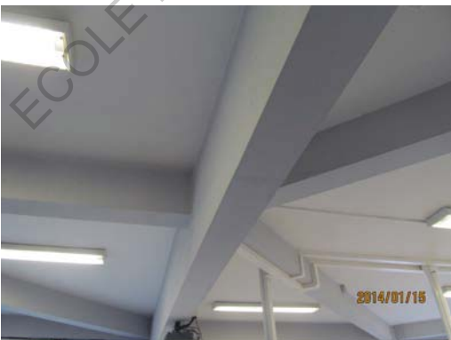
l'espace inadapté à la structure, poteaux enlevé, poutres agrandi
